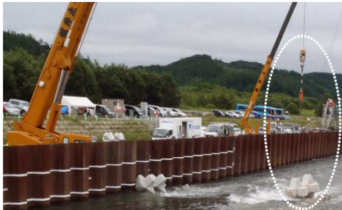
オートフックによるブロック投入状況
