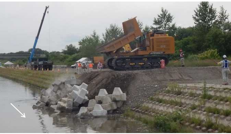
ケース6 不整地運搬車ダンプアップ ・ブロック運搬と投入を同一機械で実施、作業効率良 ・軟弱地などでも資材運搬可能、車体上部が回転し 堤防決壊箇所まで旋回可、安全性高い
