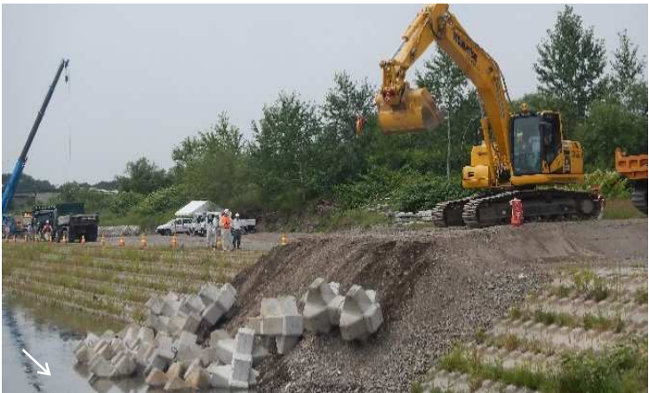
ケース5 バックホウ+オートフック直接 ・1.7分/個（決壊部に直接投入）
