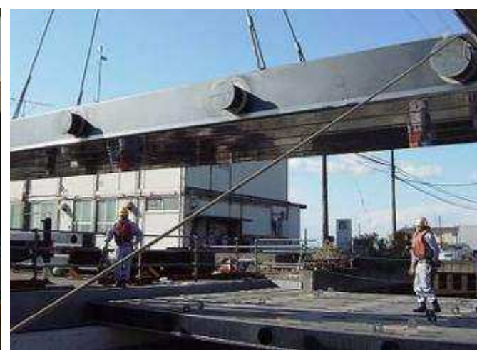
橋梁架設状況
