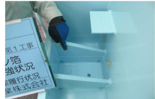
チタン箔施工部塗装完了
