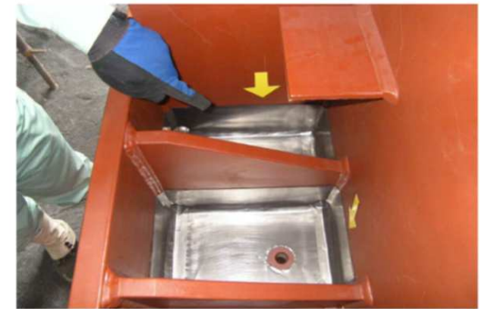
チタン箔施工状況
