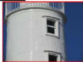
フッソ樹脂中・上塗装完了
