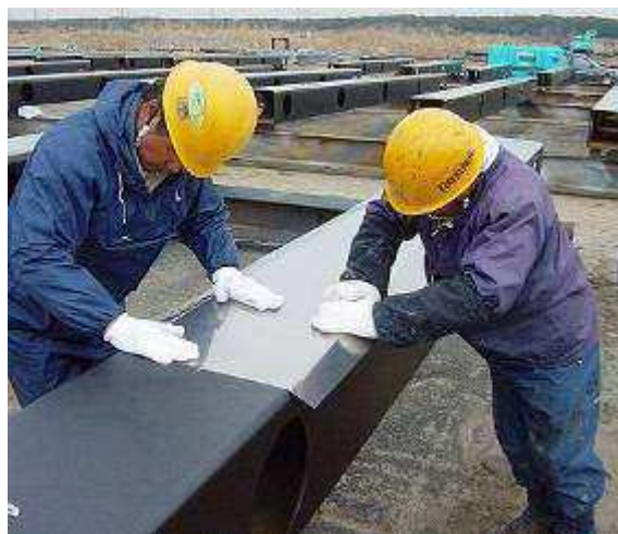
チタン箔シート貼付作業状況
