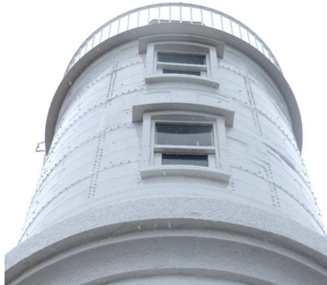
チタン箔シート貼付施工後近影
