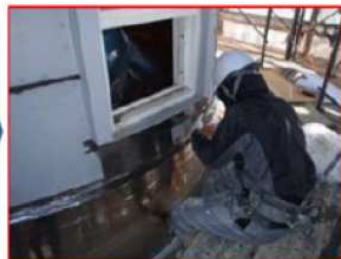
チタン箔シート貼り付け
