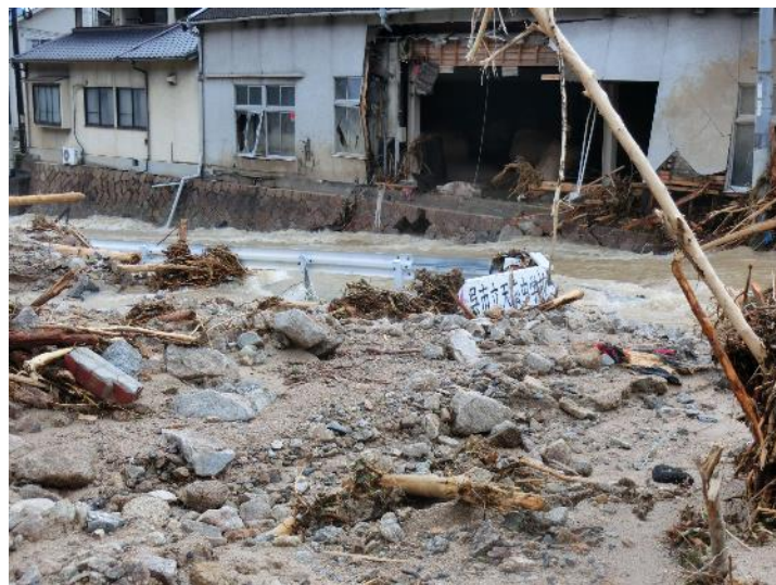
天応中学校入口の橋が土砂で埋まっている（7/8撮影）
