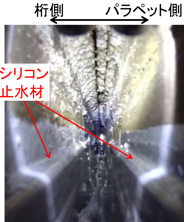
シリコン止水材の塗布後
