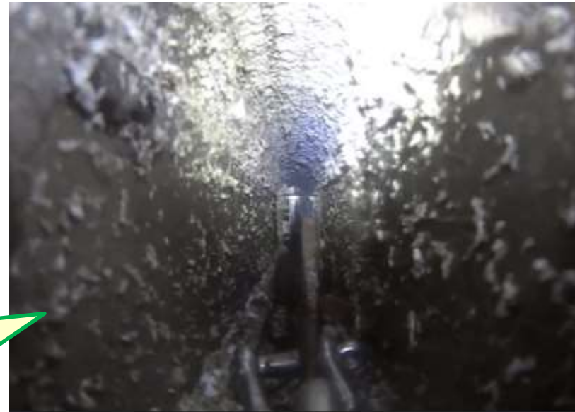
孔の拡大後の孔内部 16
