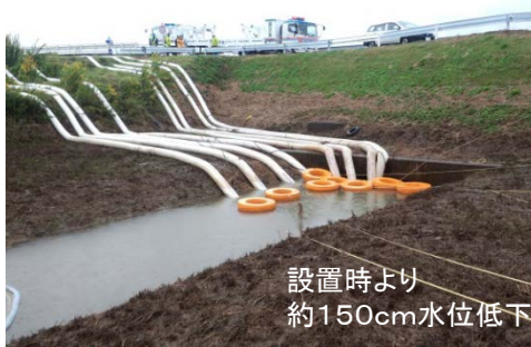
設置時より 約150cm水位低下 撮影日: 10月22日(11:00) 状 況 : 現地排水状況
