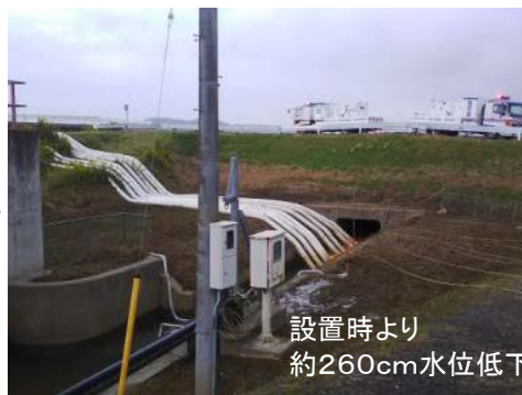
設置時より 約260cm水位低下 撮影日: 10月24日(8:00) 状 況 : 現地排水状況
