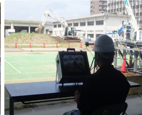
無人化施工バックホウの遠隔操縦訓練
