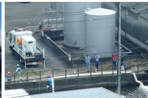
排水ポンプ車による排水作業(木曾岬町)
