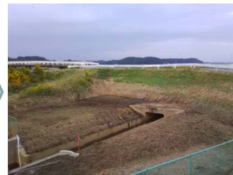
撮影日: 10月24日(15:50) 状 況 : 現地撤収作業完了
