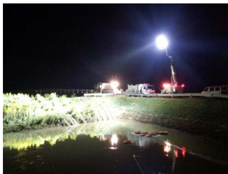
撮影日: 10月18日(17:30) 状 況 : 現地設置完了
