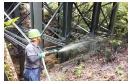
工事荒廃箇所への適用例
