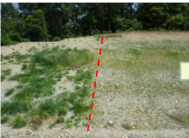
平成30年5月（施工後6.5ヶ月）
