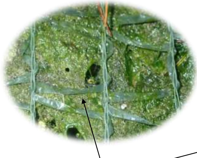
マット工の表面及び裏側の 浮いた部分にもBSCが発達
