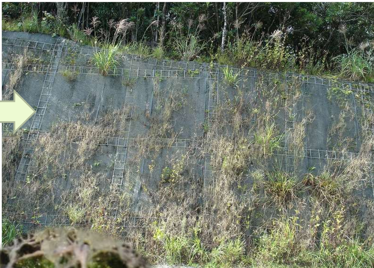
施工後（5カ月経過）
