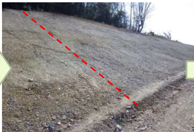
平成30年2月（施工後3.5ヶ月）
