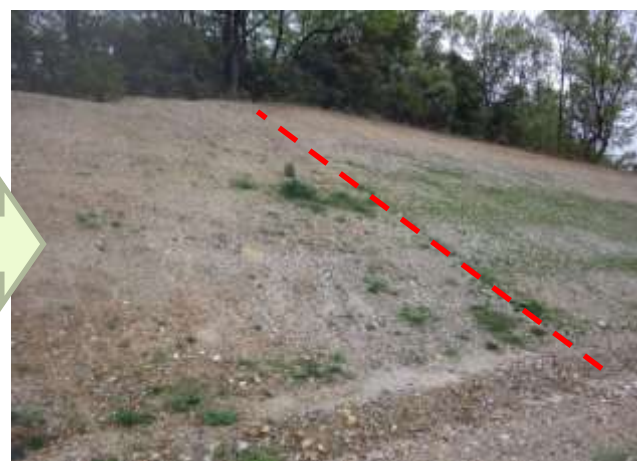
平成30年4月（施工後5ヶ月）
