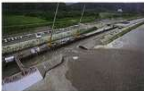
写真4 実験と堤防に併走した水路が千代田実験水路。水路幅30m、水深1.50m、全長1.1kmの室内長尺実験水路。写真には堤防の断面と水路の断面が写っている。
