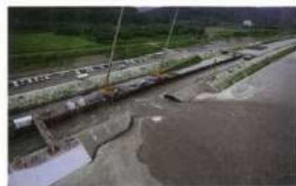
写真4 堤防と堤防に接した部分の千代田千代田実験水路。水深30m、水深幅500分の1、全長1013mの国内最大規模の河川実験施設。写真:北海道開発局寒地土木研究所
