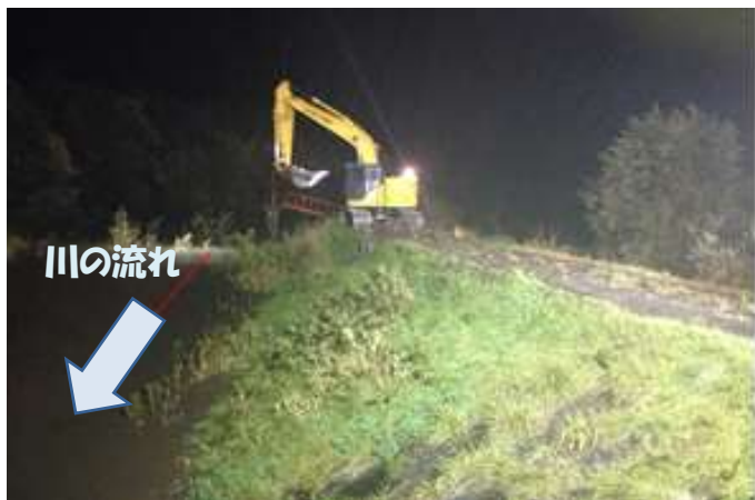
バックホウによる早期着手 (決壊発見から3時間後)
