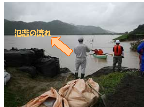
決壊開口部深掘の計測
