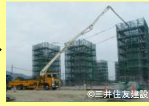
中詰めコン打設
