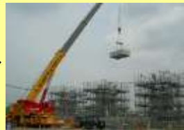
クレーンで設置
