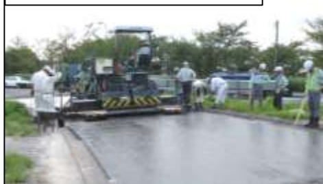
改質グース施工状況
