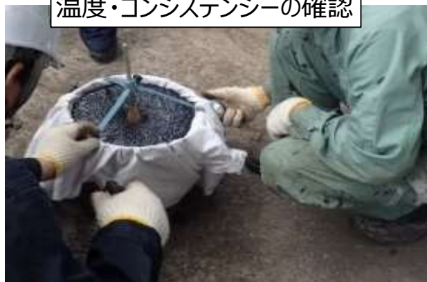
温度・コンシステンシーの確認
