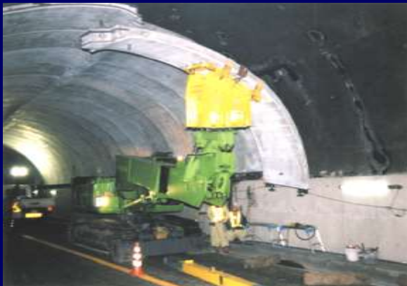
①施工写真
