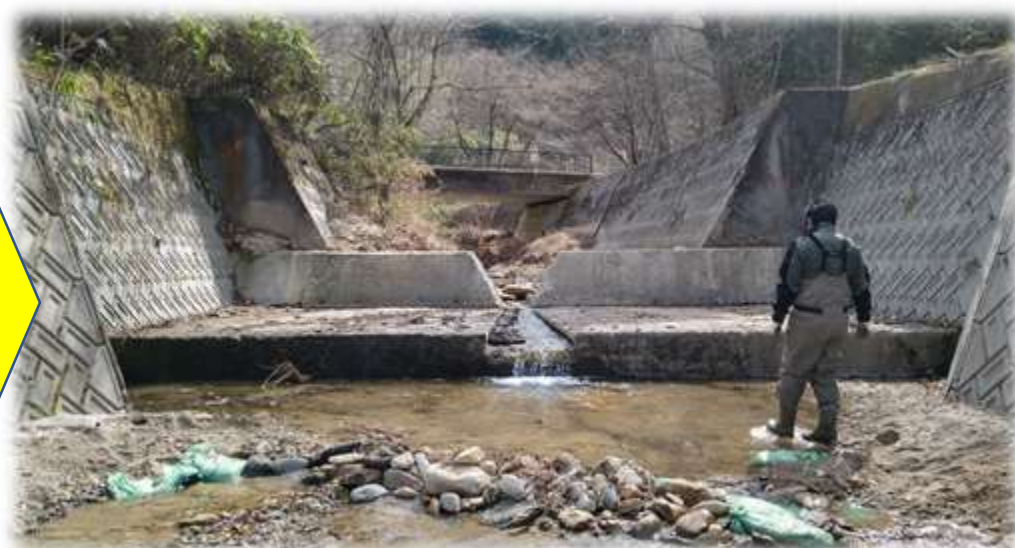
切欠き魚道 完成
