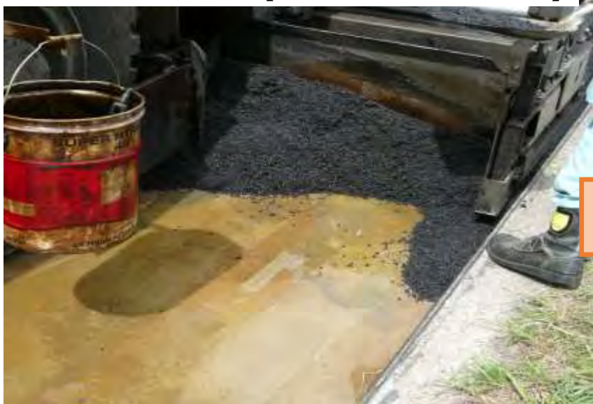
③基層の敷均し(通常のASフィニッシャ)
