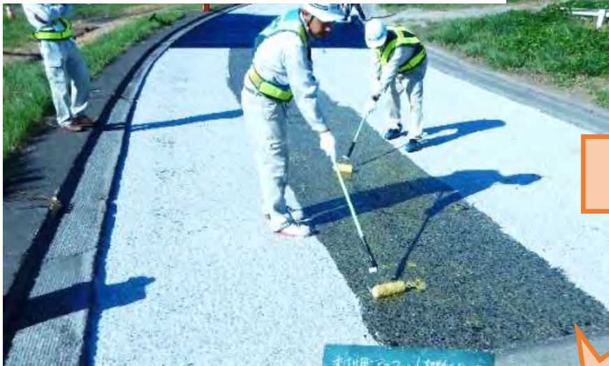
①プライマー塗布 ②珪砂の散布
