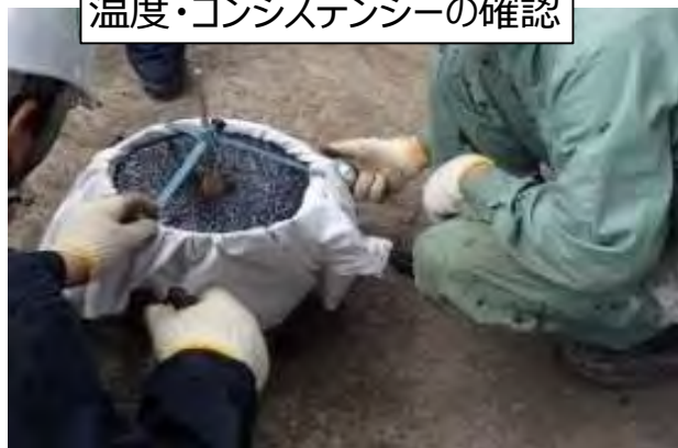
温度・コンシステンシーの確認
