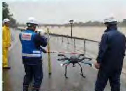
現場実装された全天候型ドローン
