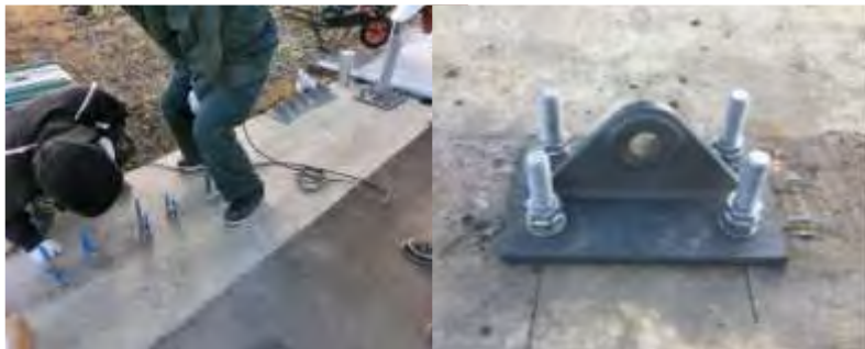
金属拡底式アンカーによる端末金具固定
