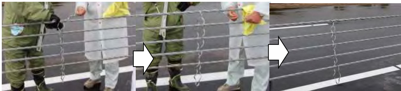
ロープ連結材の取り付け時間は1カ所当たり約1分
