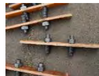
アンカーボルトの型枠
