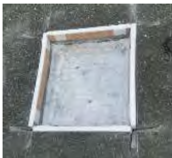
防水材の溝の型枠
