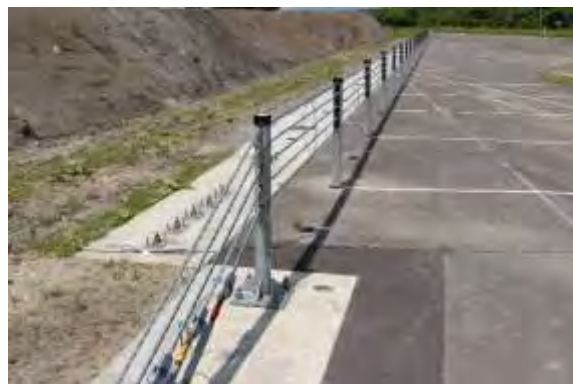
防護柵設置状況 (端末)
