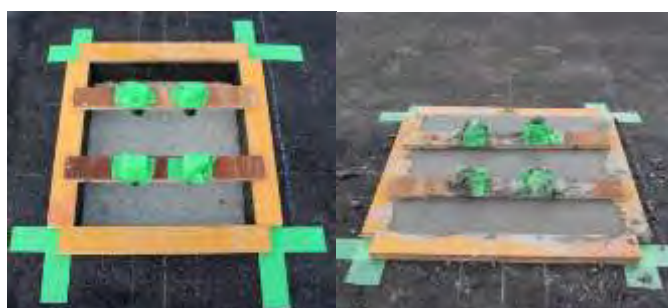
型枠の設置とコンクリート打設
