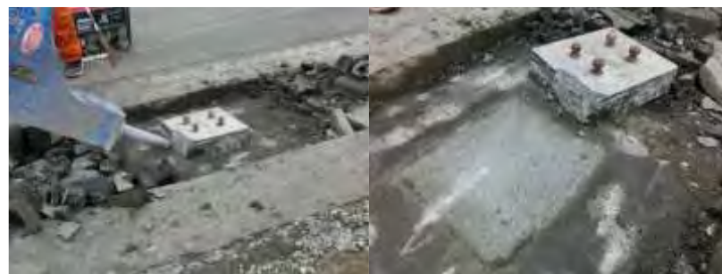
基礎コンクリートの撤去
