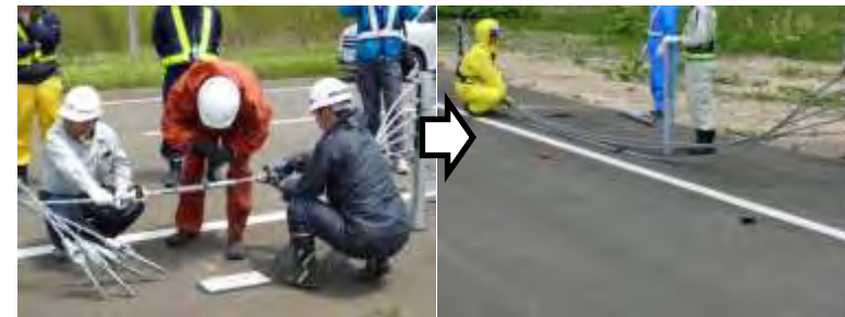
支柱は人力で脱着し、開口部を設置
