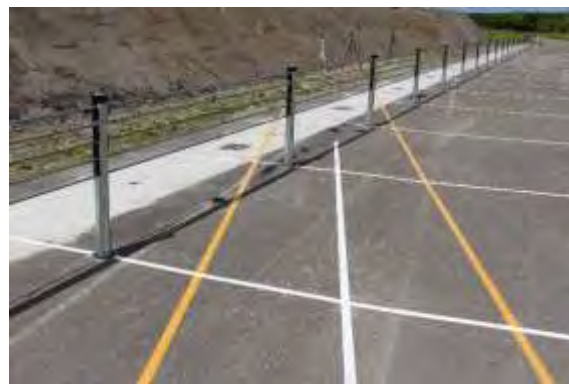
防護柵設置状況 (中間支柱)
