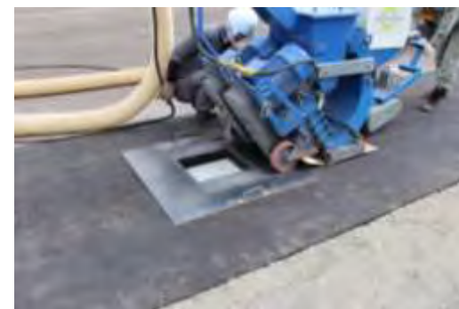
鉄製型枠を使用したブラスト工法
