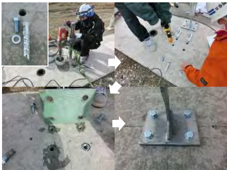
接着系めねじアンカーの施工状況
