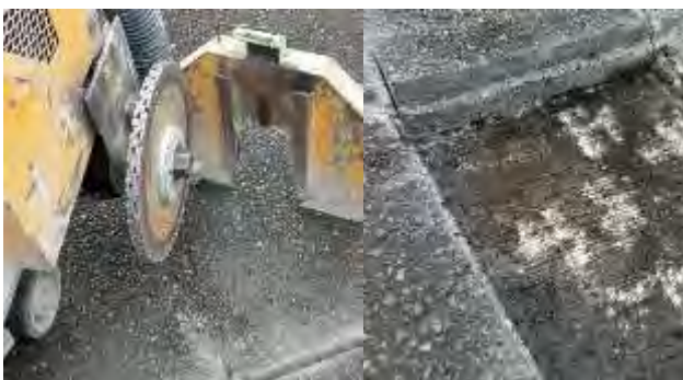
目地カッターで防水材施工溝を事前に施工
