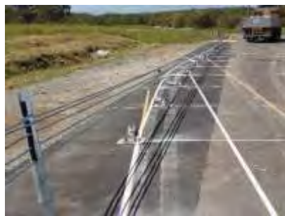
衝突試験後の状況
