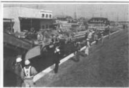
当日は、下り側ランプの延長190mを舗装した
