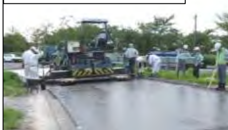
改質グース施工状況
