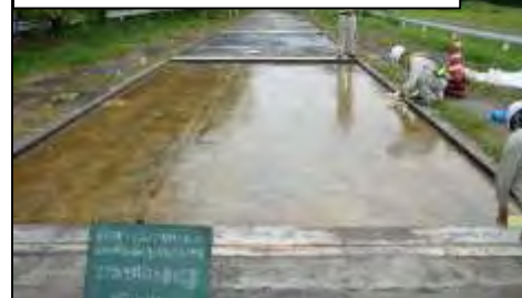
樹脂防水材料施工状況
