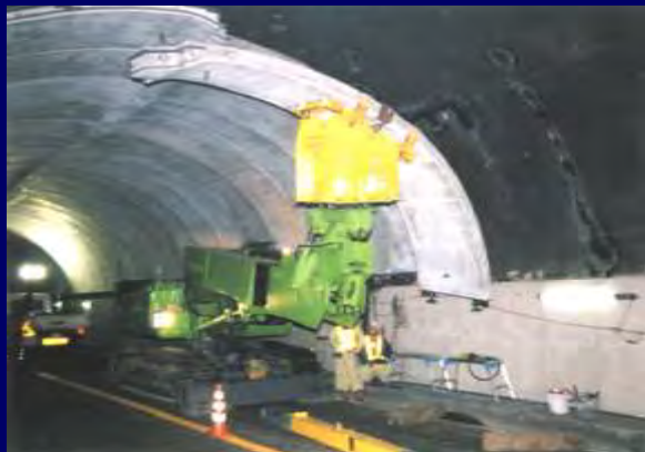
①施工写真
