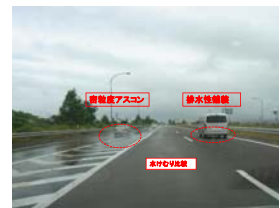
走行車の水けむりの比較 (密粒度アスコンと排水性舗装)
