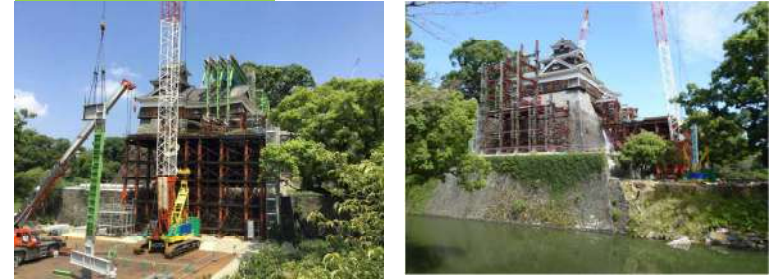
受構台設置工事(H29. 9月)
