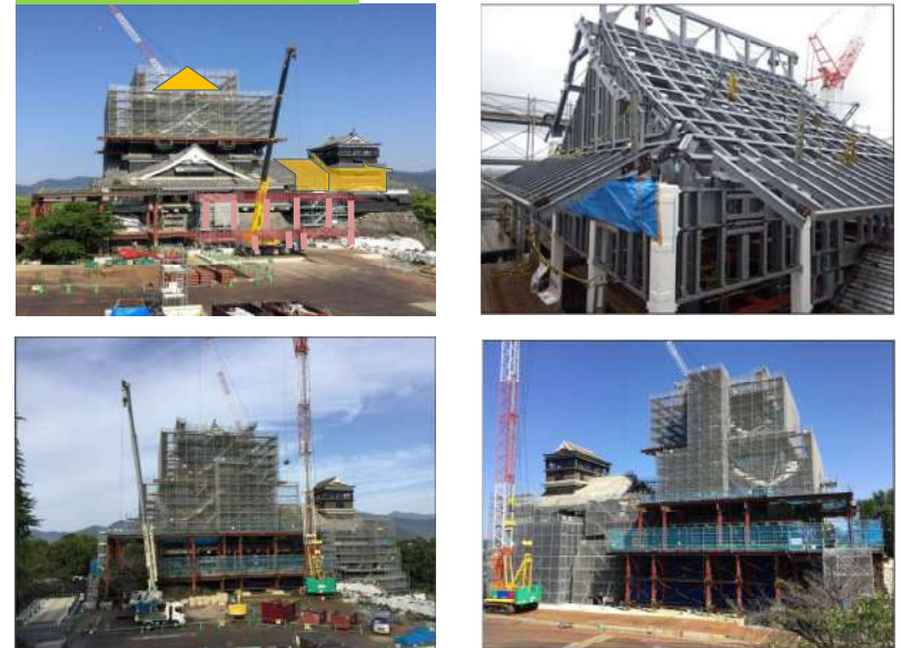
天守閣復旧整備事業(H29. 10月)
