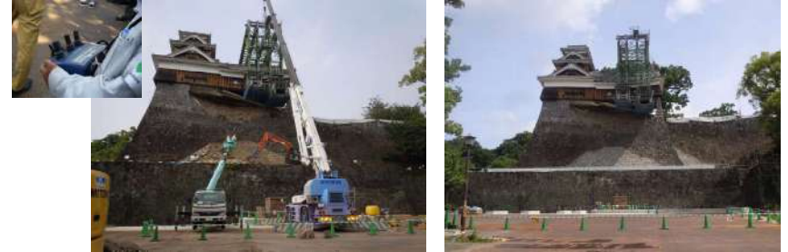
受構台設置工事(H29. 9月)
