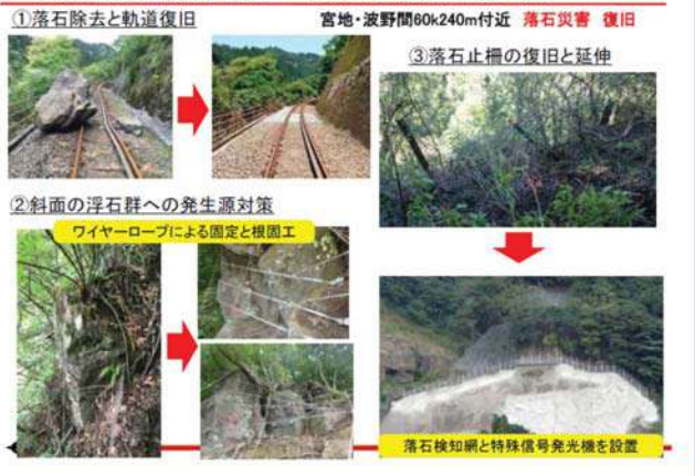
土木学会 2016年熊本地震1周年報告会 公開資料より 107
