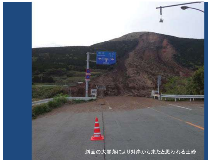
斜面の大崩落により崩壊した阿蘇大橋 南阿蘇
