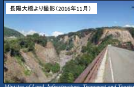
長陽大橋より撮影(2016年11月)
