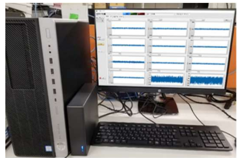
モニタリングシステム 機場設置のデータ収録装置
