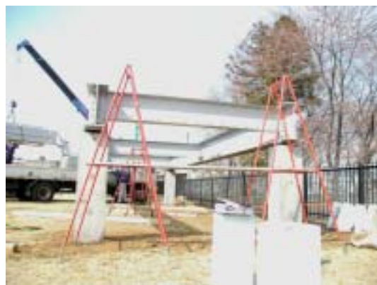
図 4.4.14 横桁取り付け完了
