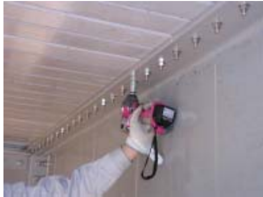
図 4.4.17 床版部材の固定
