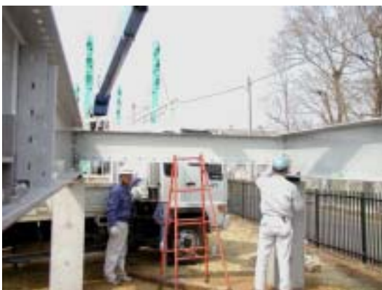
図 4.4.13 横桁および補剛材の固定
