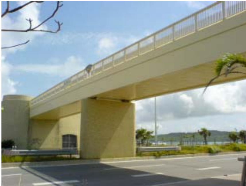
図 2.1.11 伊計平良川線ロードパーク橋
