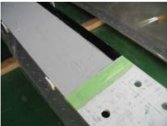
図 4.4.6 下フランジへのCFRPの接着
