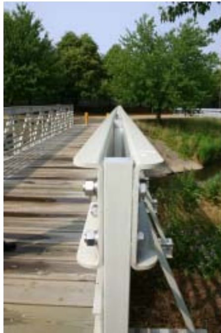
図 2.1.3 Middlebury Run Bridge の主部材断面
