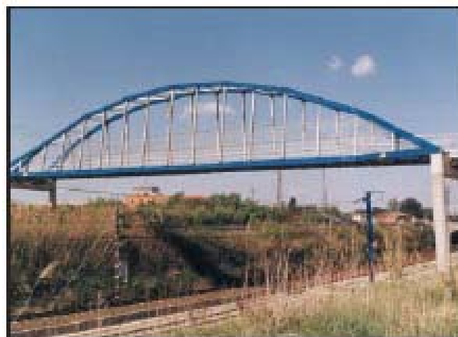
図2.1.10 Lleida 橋の外観
