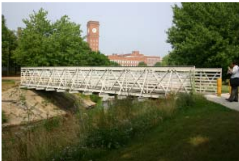
図 2.1.1 Middlebury Run Bridge の外観写真
