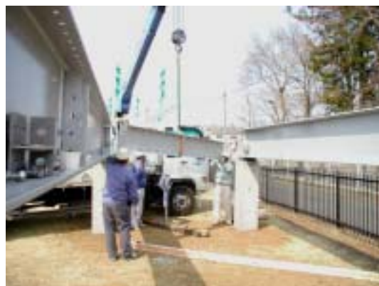
図 4.4.12 横桁部材の取り付け (1本目)
