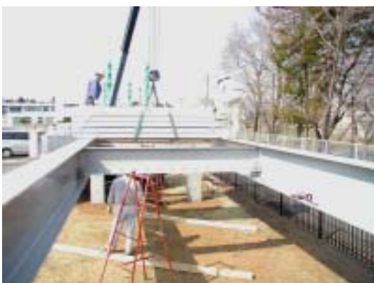
図 4.4.15 床版部材の仮置き
