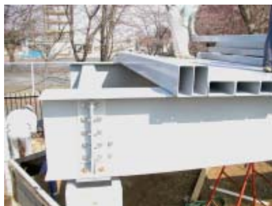
図 4.4.16 床版部材位置あわせ
