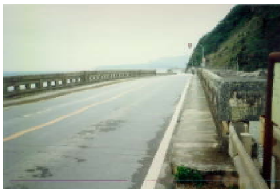
図3.1 歩道のない道路橋の例
