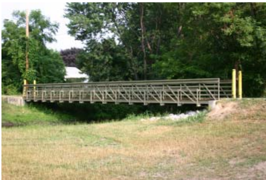
図 2.1.5 Carey Avenue Bridge の外観写真
