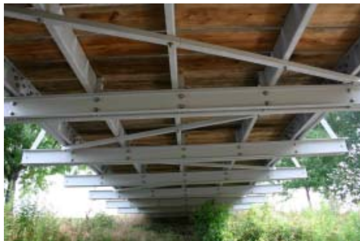
図 2.1.4 Middlebury Run Bridge の外観写真(下面)
