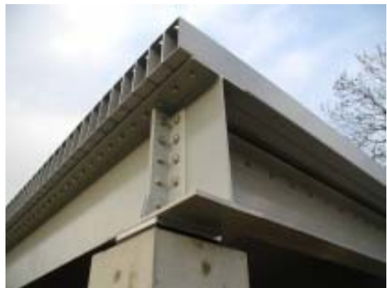
図 4.4.20 完成後端部アップ
