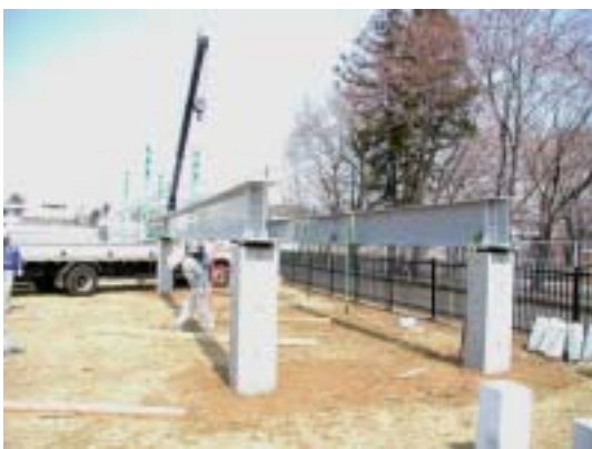
図 4.4.11 主桁部材の架設
