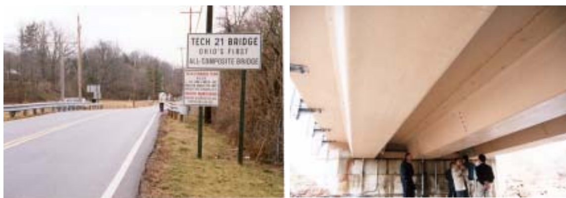
図 2.1.12 FRP 道路橋の事例 1 (TECH21)
