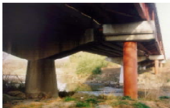
図3.3 左の下部工の様子 (基礎が新設されている)
