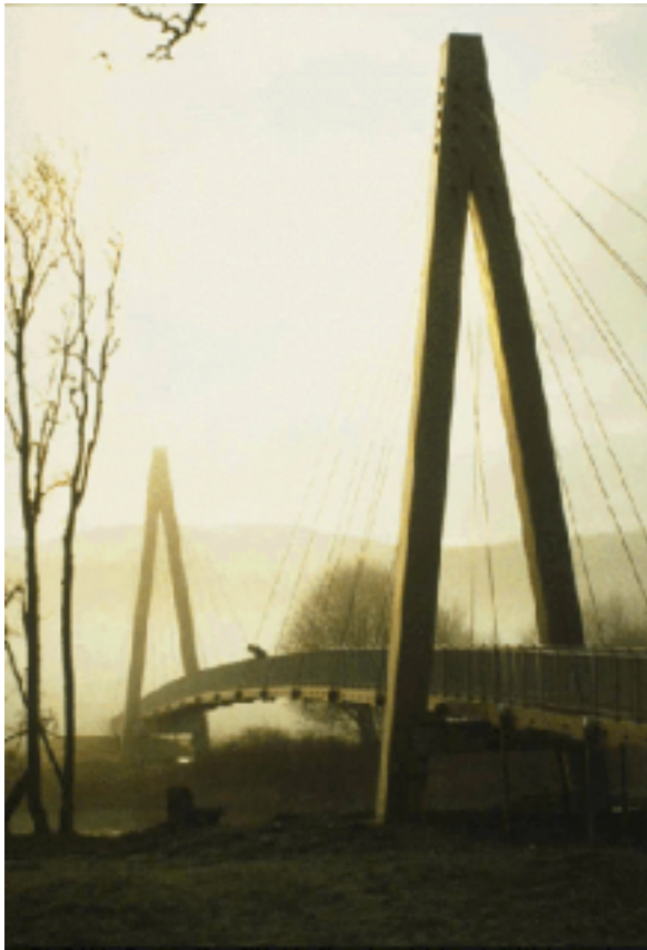
図 2.1.8 Aberfeldy 橋の写真
