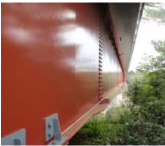
補強桁下の孔食部の塗装後の状態
