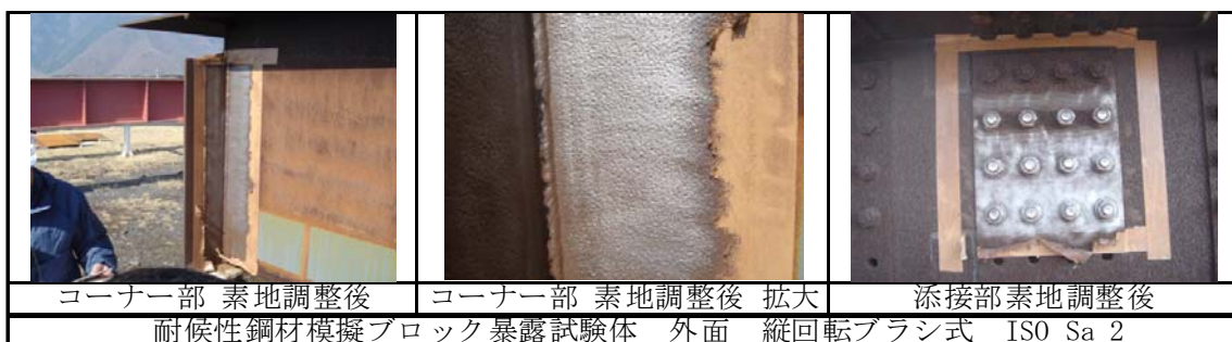
図-4.4.12 動力工具処理面の状態
