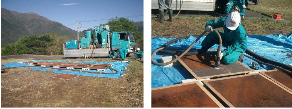
写真-4.4.4 バキュームブラスト処理実施状況
