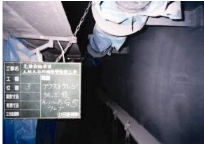
写真-3.3.3 素地調整（ブラスト）の状況（五郎太谷川橋）
