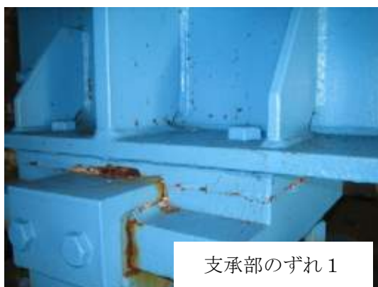
写真-3.3.11 塗膜異常部 (五郎太谷川橋)
