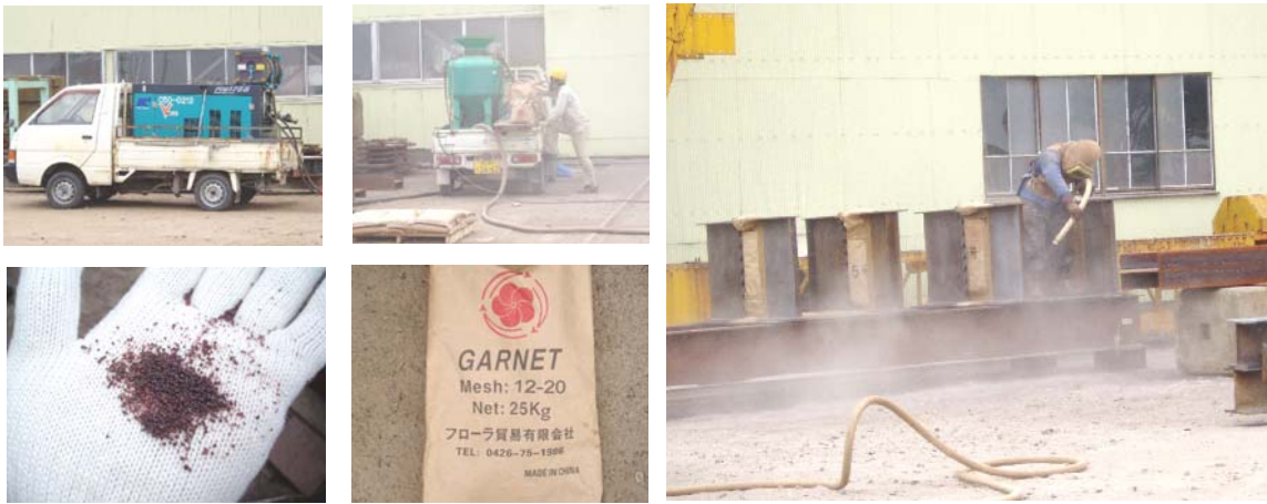
写真-4.3.5 素地調整時の状況
