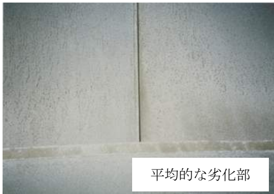
写真-3.3.1 補修塗装前の溶融亜鉛めっきの状態（五郎太谷川橋）
