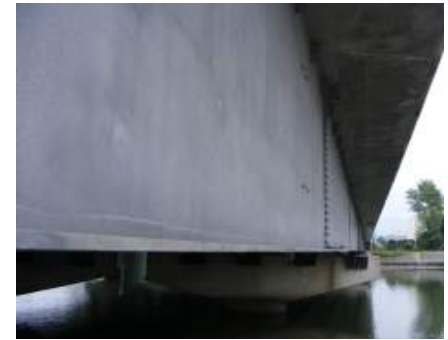
腹板上流側（市道西行き側）
