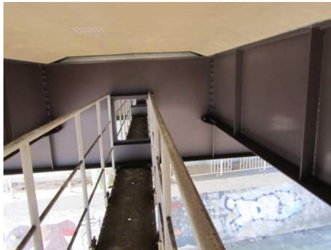
写真-3.2.4 内桁の状況
