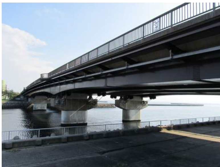
写真-3.2.2 箱桁外面 (陸側)
