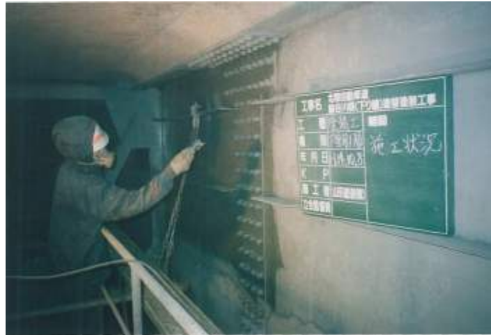
写真-3.3.8 補修塗装時の状況（脇谷川橋）
