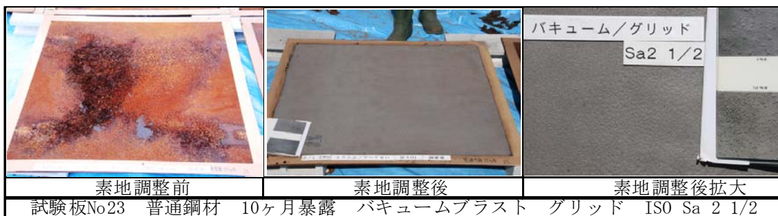
図-4.4.5 バキュームブラスト処理面の状態
