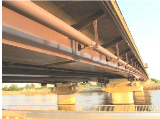
写真-3.2.3 箱桁外面（海側）
