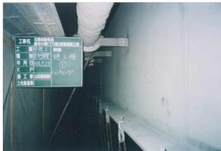
写真-3.3.7 素地調整後の状態（脇谷川橋）
