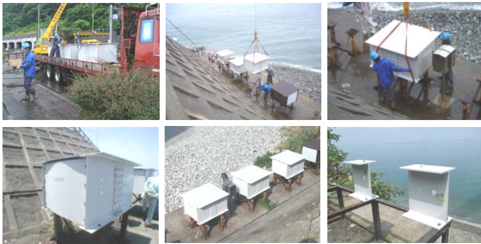
写真-4.3.8 試験体の設置状況
