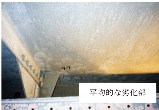
写真-3.3.2 補修塗装前の溶融亜鉛めっきの状態（脇谷川橋）
