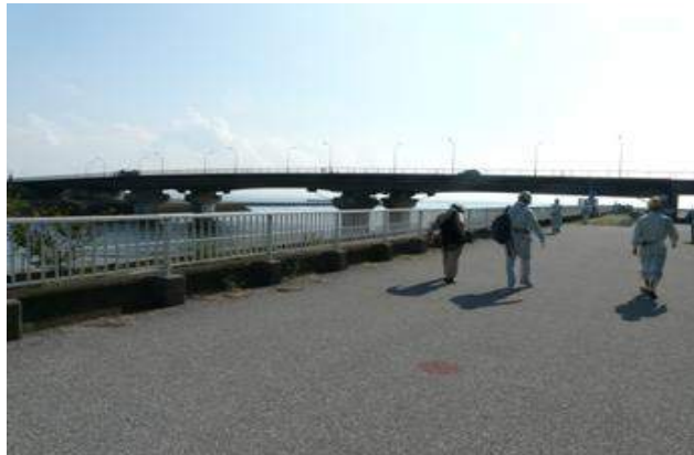
写真-3.2.1 美浜大橋全景
