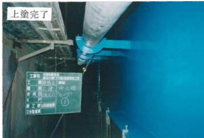
写真-3.3.9 塗装後の状態（脇谷川橋）
