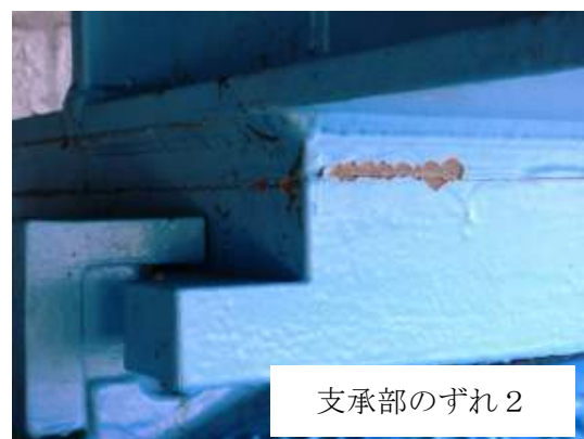
写真-3.3.11 塗膜異常部 (五郎太谷川橋)
