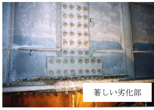
写真-3.3.2 補修塗装前の溶融亜鉛めっきの状態（脇谷川橋）
