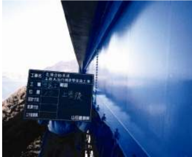
写真-3.3.5 塗装後の状態（五郎太谷川橋）
