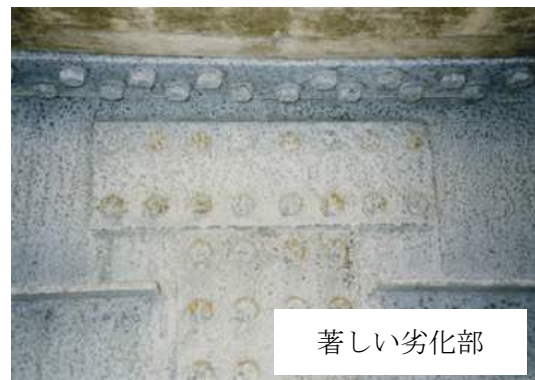
写真-3.3.1 補修塗装前の溶融亜鉛めっきの状態（五郎太谷川橋）
