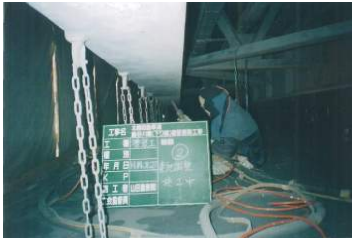
写真-3.3.6 素地調整（ブラスト）の状況（脇谷川橋）
