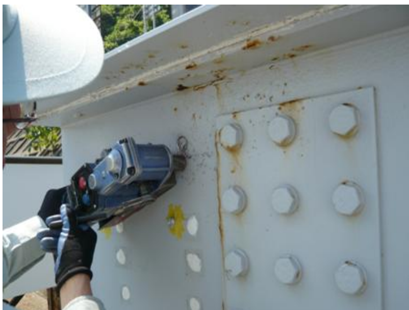
写真-4.5.2 コア材採取状況
