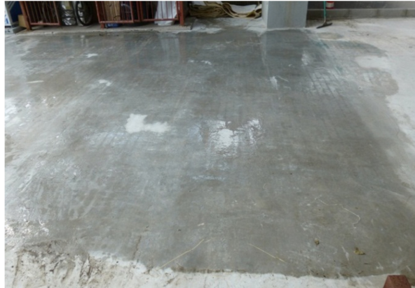
写真-3 養生完了後の状況
