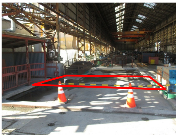
写真ー1 施工前の状況
