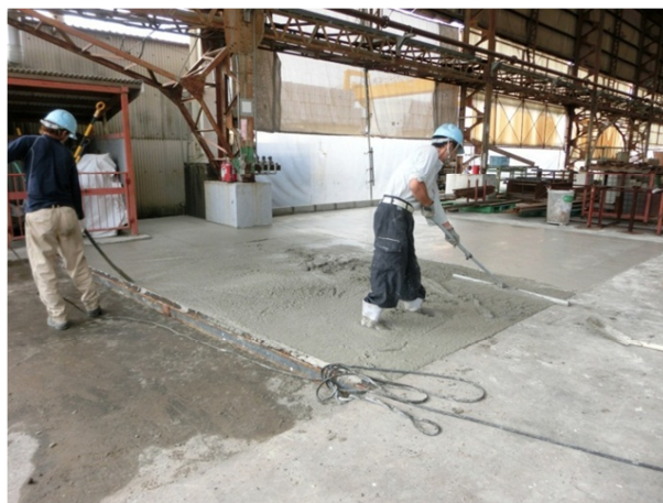
b) 締固め及び均しの状況
