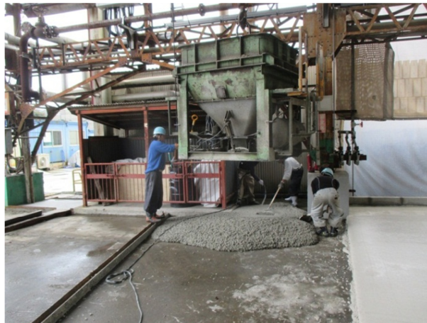
a) バケットによる打込み状況
