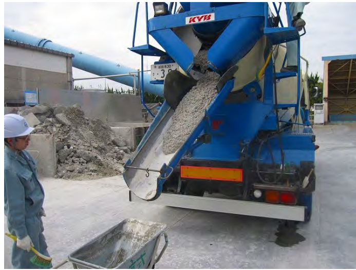
写真-3 高炉スラグ微粉末を高含有したコンクリートのトラックアジテータからの荷卸し状況
