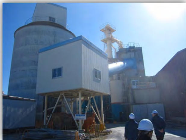
写真ー1 戸田建設株式会社 成田PC工場内 コンクリート製造設備
