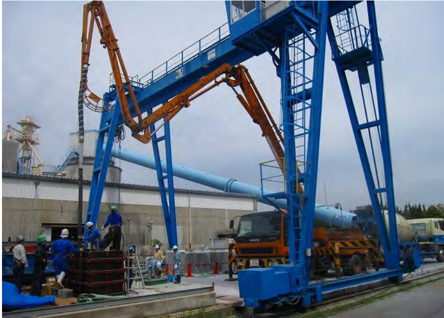
写真-5 コンクリートの打込み状況
