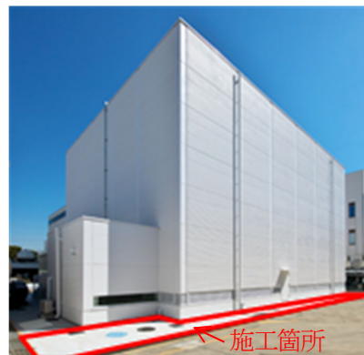
b) 施工完了
