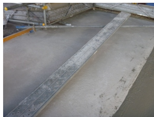
b) 仕上げ後の状況
