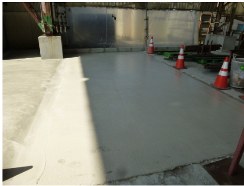
写真-9 養生終了後の状況
