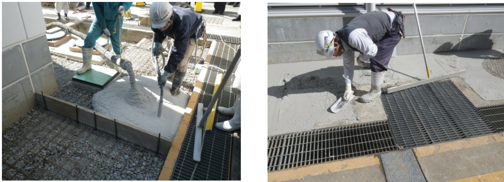
a) 打込みの状況
