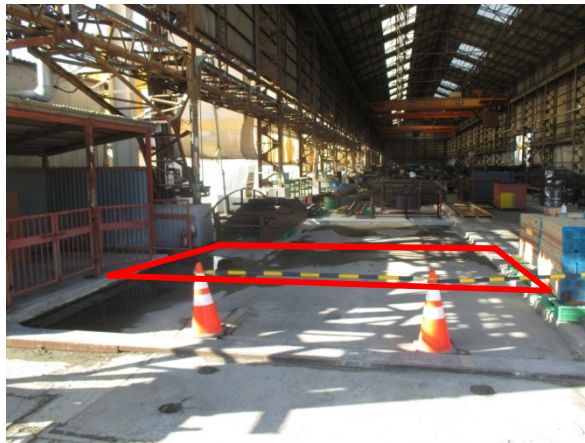
写真-7 施工前の状況
