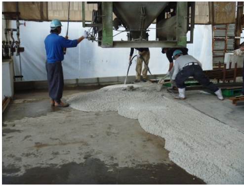
a) バケットによる打込み状況
