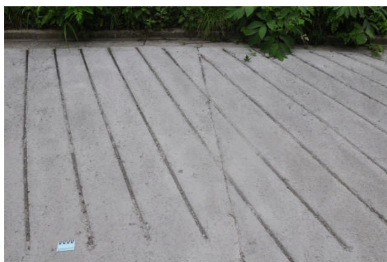
写真 7.4.4.1 滑り止め用のスリット
