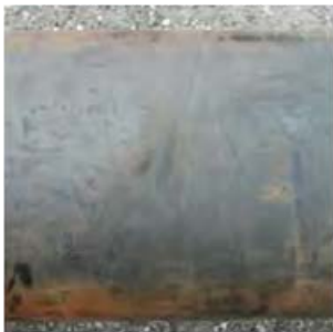
③海生生物(フジツボ類)の付着跡(被覆材に異状は認められない)
