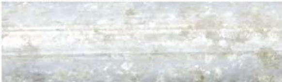
②干渉帯におけるチタン板溶接部(異状なし)
