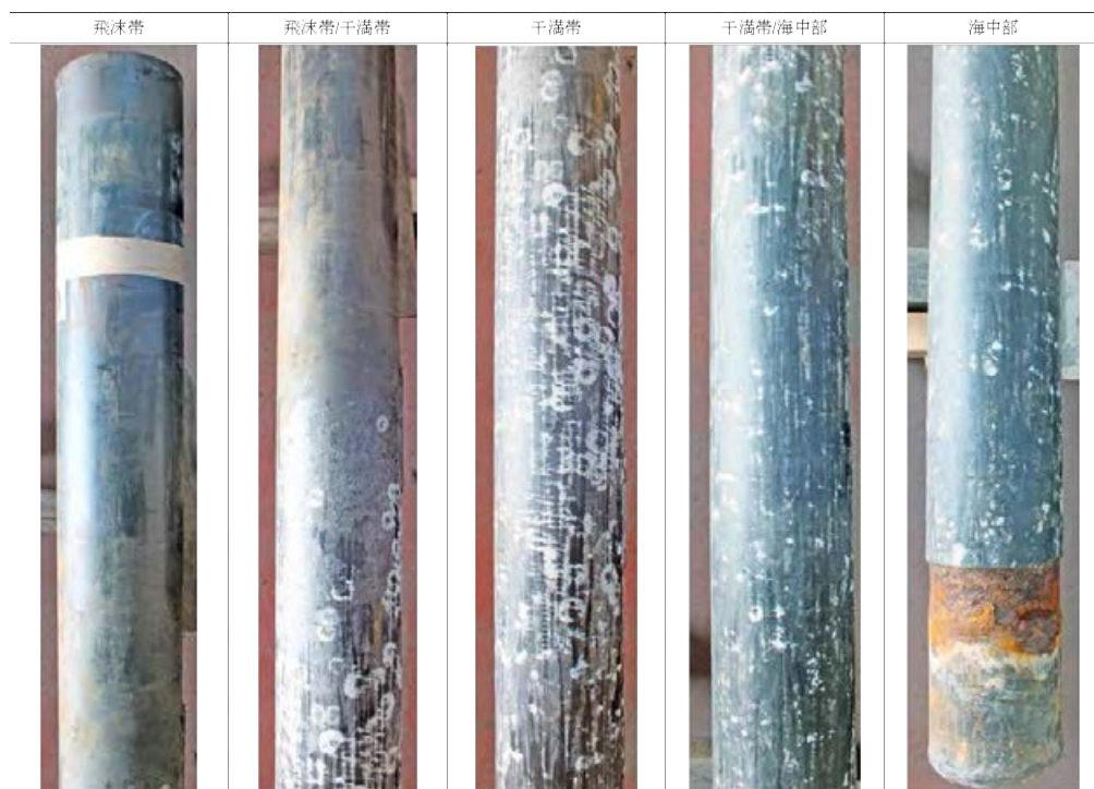
写真-3. 3. 3. 6 N-3 材の各部位における外観(南側)
