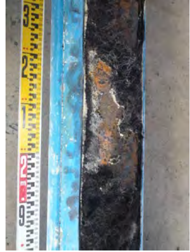
鋼管素地面の外観状況 (部位②)
