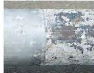
③高耐食性SUS溶接部に異状は認められない
