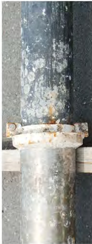
②チタンカバナー補修部およびタールエポキシ塗装部に損傷は認められず、異状はない(T.P.±0付近)
