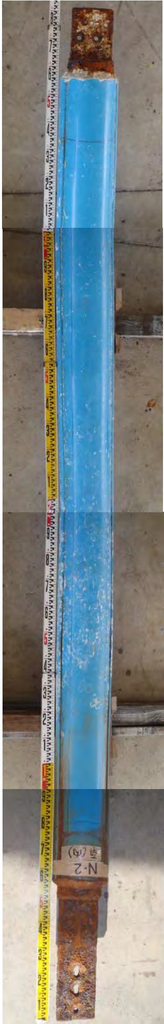
N-2 (FRP保護カバー開放前の外観状況)
