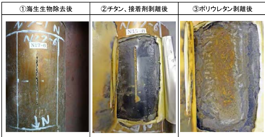
③錆落とし後に計測した板厚減少量
