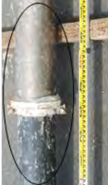
②チタンカバナー補修部およびタールエポキシ塗装部に損傷は認められず、異状はない(L.W.L付近)
