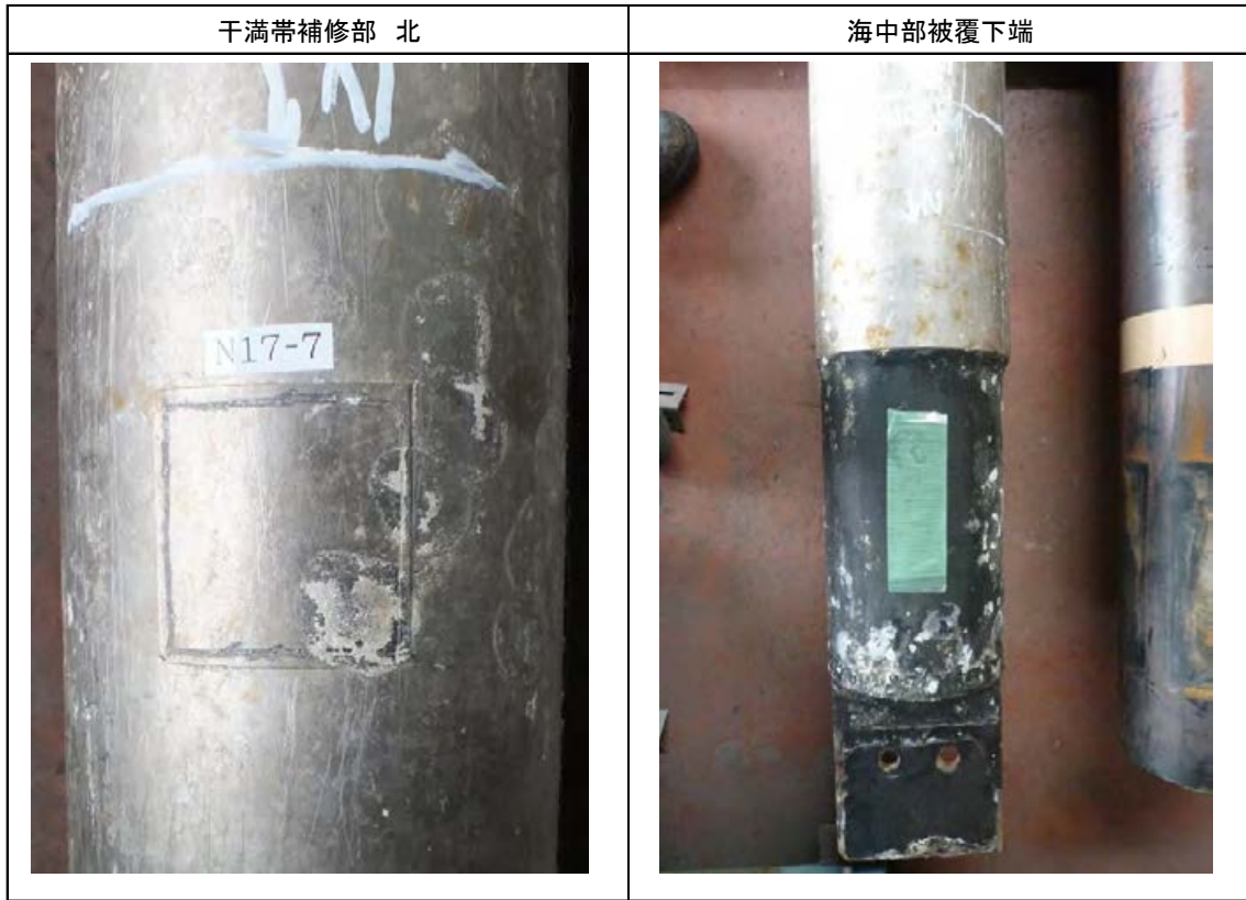
写真-3.3.17.9 N-17 試験材の補修部、被覆下端部の外観
