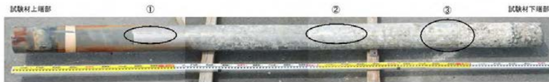
①飛沫帯におけるチタン板溶接部(異状なし)
