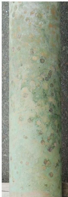
②干満帯上部に海生生物（フジツボ）の付着痕が認められる
