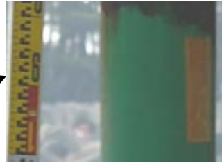
補修部外観状況
