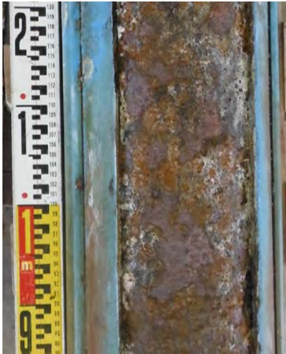
試験鋼管素地面の外観状況 (部位①：飛沫帯部)
