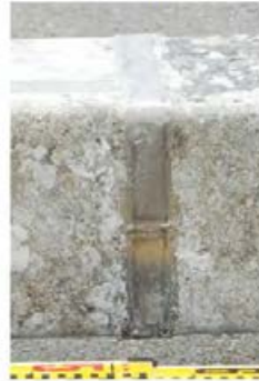
②溶接部状況(局部腐食なし)
