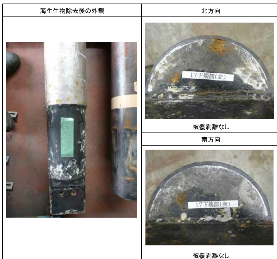
写真-3.3.17.15 被覆下端部の外観（海中部）
