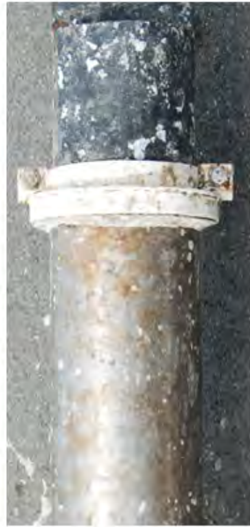
②チタンカバナー補修部およびタールエポキシ塗装部に損傷は認められず、異状はない(L.W.L付近)
