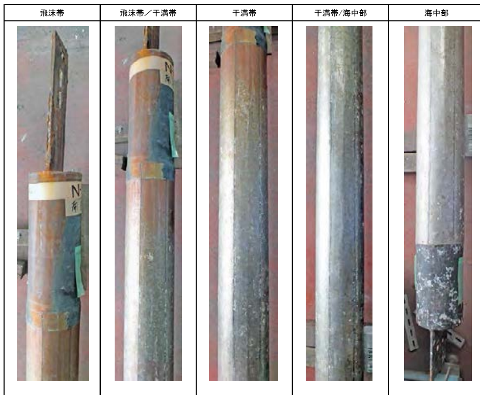
写真-3.3.17.4 N-17 試験材(西側)の各部(飛沫部～海中部)の外観
