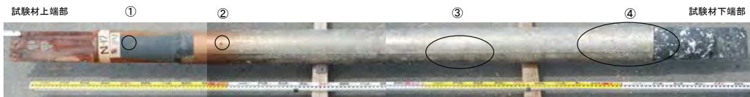
①衝撃痕部(塗膜に割れが生じ発錆が認められる)
