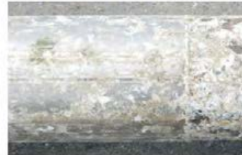
③海中におけるチタン板溶接部(異状なし)
