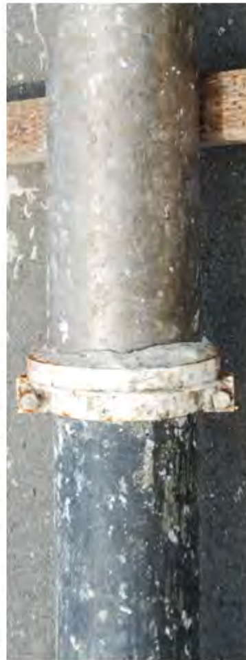
②チタンカバナー補修部およびタールエポキシ塗装部に損傷は認められず、異状はない(T.P.±0付近)
