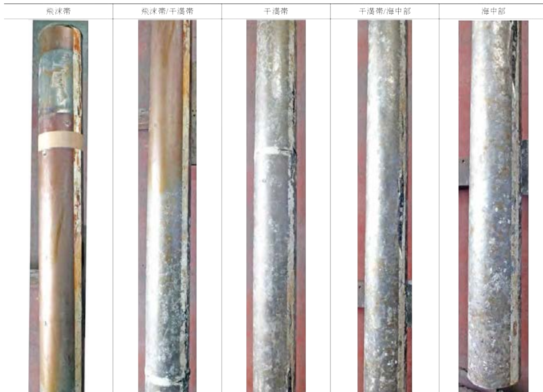
写真-3.3.15.6 N-15 試験材(北側)の各部(飛沫部~海中部)の外観
