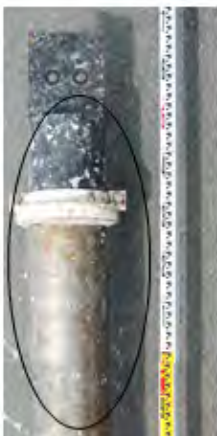
②チタンカバナー補修部およびタールエポキシ塗装部に損傷は認められず、異状はない(L.W.L付近)
