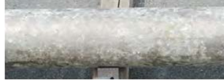
④被覆端部のシール材に一部欠損が認められる
