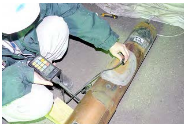
写真-3.3.14.12 スクラッチ傷の剥離部の板厚測定状況
