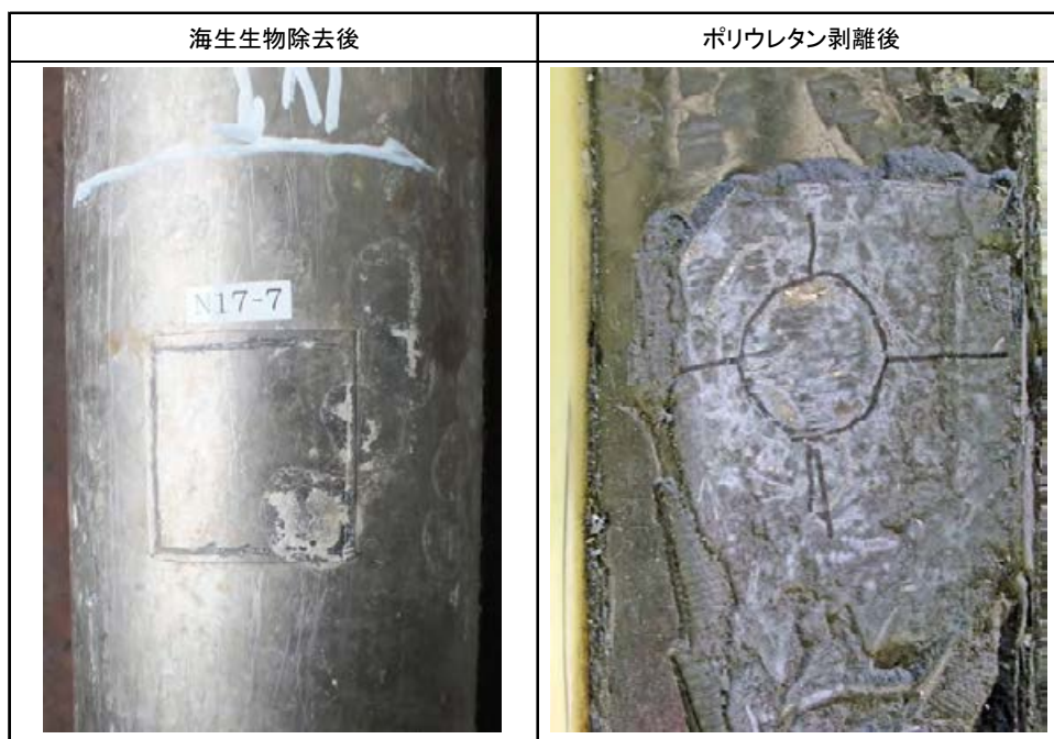
写真-3.3.17.14 補修部の外観（干満帯）
