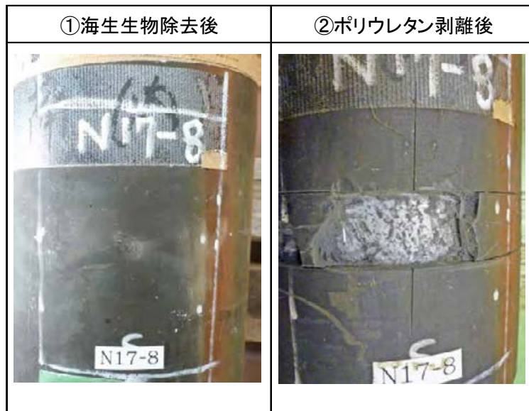
写真-3.3.17.12 人工欠陥部（打撃痕）の外観（飛沫帯上部）
