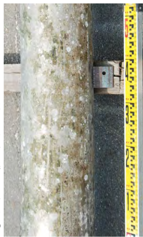
③一般部および接合部に異状は認められない
