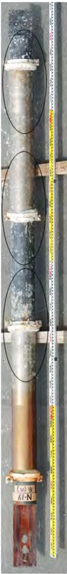
②チタンカバナー補修部およびタールエポキシ塗装部に損傷は認められず、異状はない(L.W.L付近)
