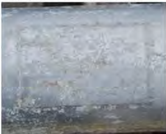
②補修部(一般部、溶接部とも異状なし)
