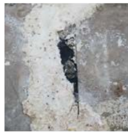
①衝撃痕部(チタン箔が剥離し鋼管が露出) ②シール材およびチタン箔の欠損 ③シール材およびチタン箔の欠損 ④衝撃痕部(異常なし)
