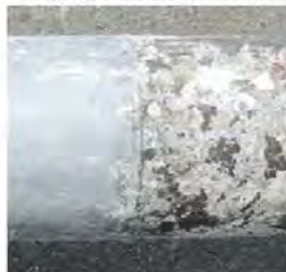
③高耐食性SUS溶接部に異状は認められない
