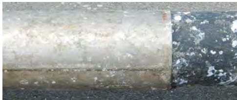
④チタン被覆部の一般部および溶接部(異状なし)
