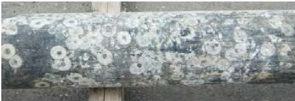
③海生生物(フジツボ類)の付着跡(被覆材に異状は認められない)
