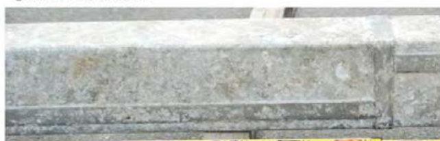
②溶接部状況(局部腐食なし)
