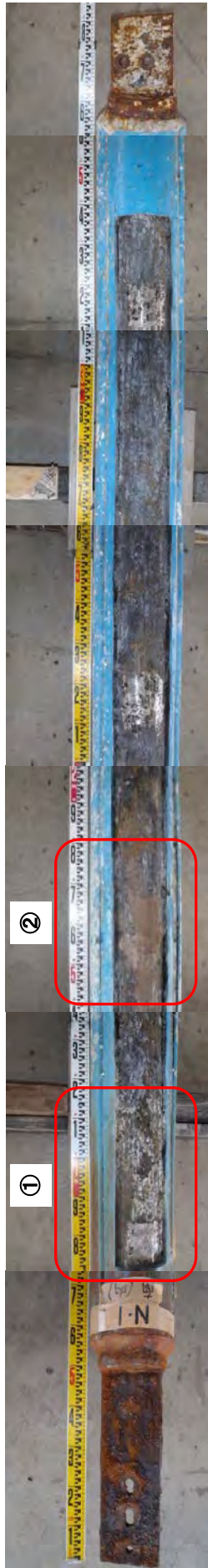
N-1 (ウレタン系防食樹脂除去後の鋼管素地面状況)
