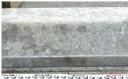
①溶接部状況(局部腐食なし)
