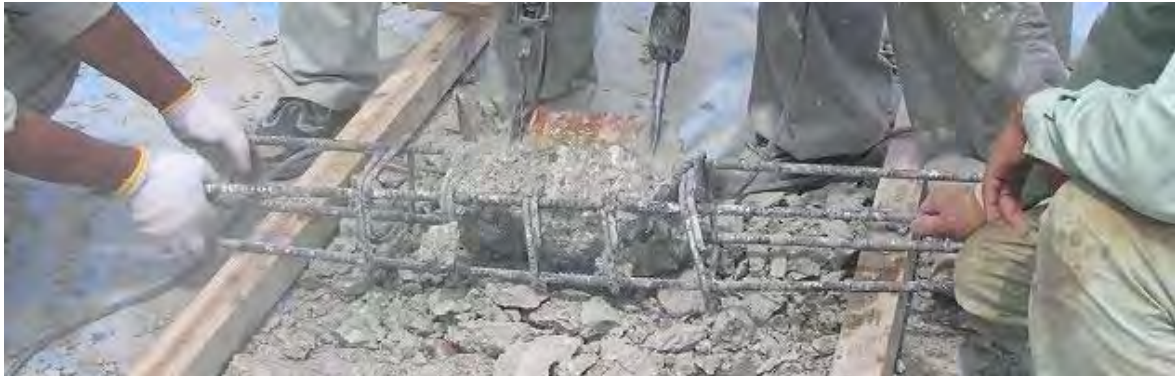
写真-資 7.1 コンクリート中の鉄筋はつり出し状況
