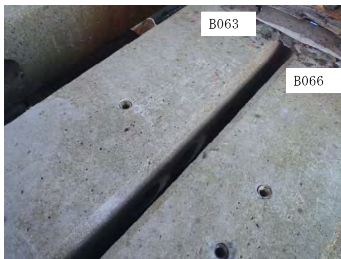
写真-4.1.4 含浸系塗装試験体
