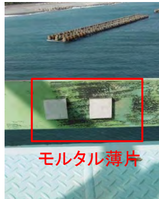
b) 観測塔上段南面(高欄部)
