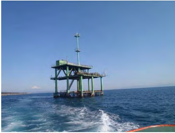
写真-資 3.1 暴露試験場
