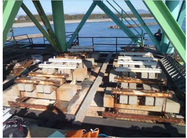
写真-資 3.2 暴露状況
