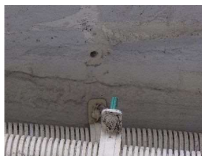
写真 1.8 固定ビスの抜け落ち
