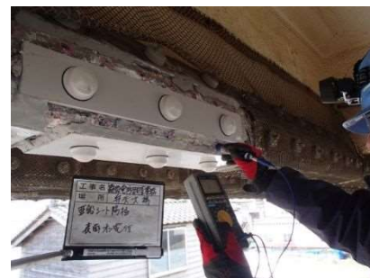
写真 5.6 代替防食板周囲 ON 電位計測
