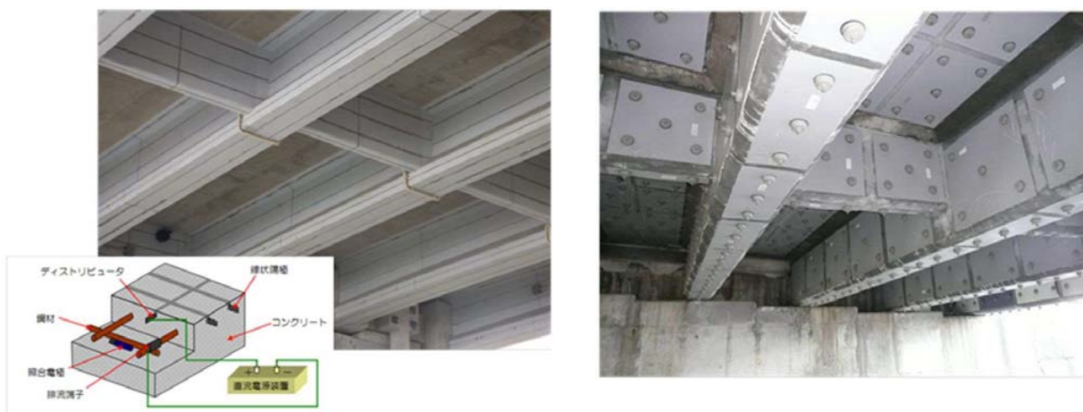
b)流電陽極方式の例
