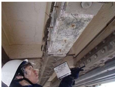
写真 5.3 コンクリート表面確認
