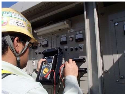
鋼材電位の確認
