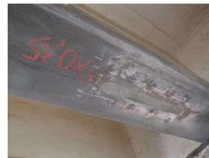
写真 3.4 モルタル被覆完了
