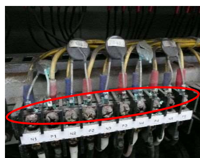
腐食した端子の交換
