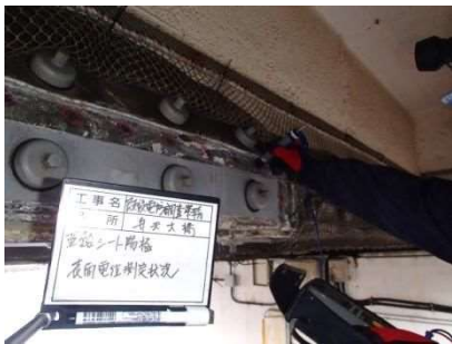
写真 5.5 既設防食板周囲 ON 電位計測
