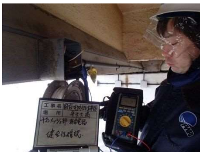
写真 4.3 電位値確認状況
