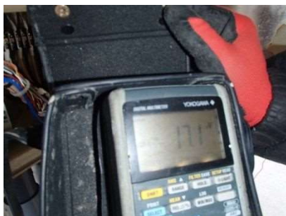
写真 4.1 電位値不安定 (17.1mV)
