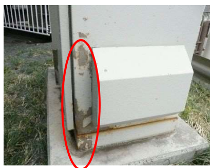
塗装劣化、腐食部のタッチアップ
