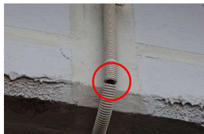
脱落部の補修, 割れた配管材の交換
