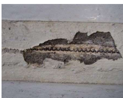
写真 1.11 陽極材の露出 (縦入れチタンリボンメッシュ方式)
