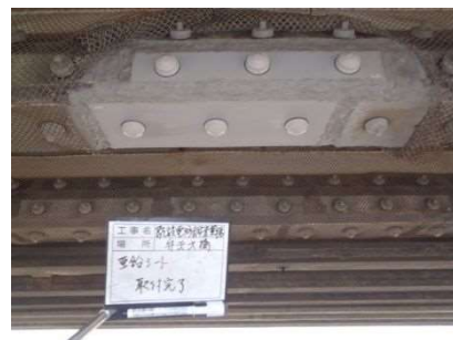
写真 5.4 代替防食板設置完了
