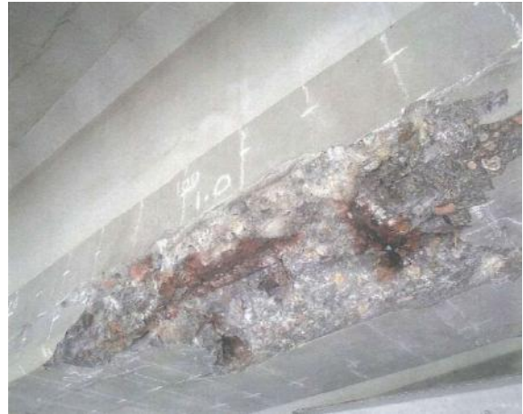
写真-2.1.5 はつり後の鋼材の状況 (スパン2 G2桁)
