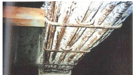
電気防食施工前 (G6 桁) (平成 10 年度荒磯橋他 24 橋調査設計業務報告書より)
