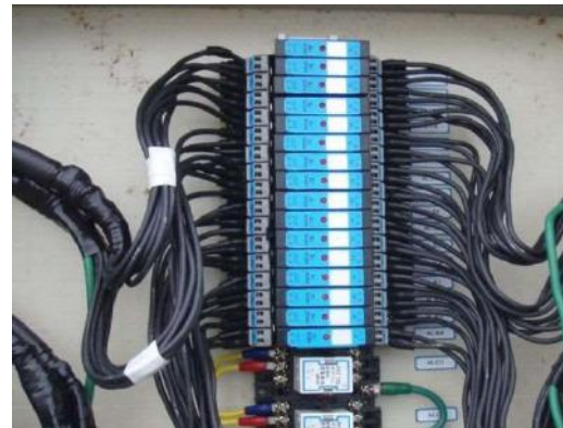
写真-4.4.11 サージアブソーバーの増強
