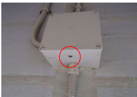
写真-3.4.3 底面水抜き孔の確認
