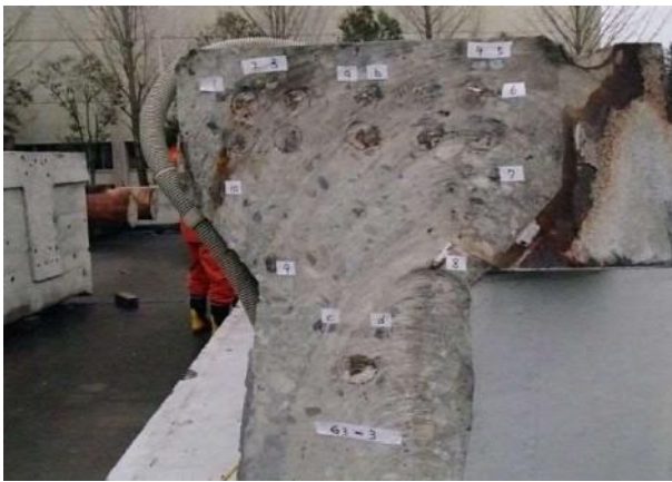
写真-3.1.1 G3-3における鉄筋間導通確認試験
