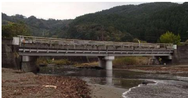
C橋全景 (海側より)
