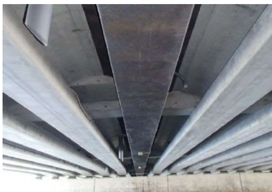
写真-6.5.1 チタン溶射方式（No. 1 回路）※後施工
