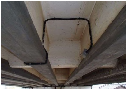
写真-3.3.3 チタングリッド方式 (桁横断部配管状況)
