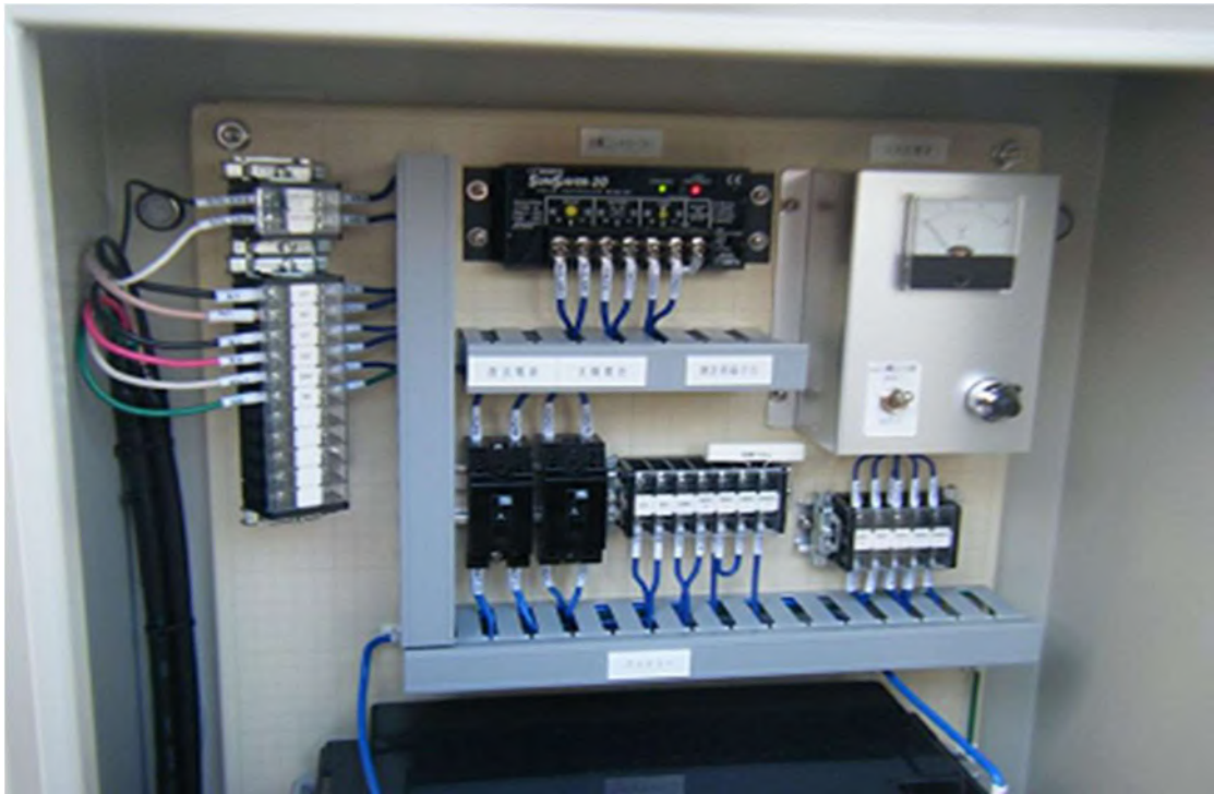
写真-3.3.25 ECP パネル方式・桁端電気防食工法（三井住友建設）
