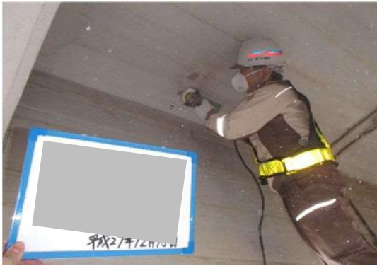
写真-3.7.1 G1桁ケレン状況
