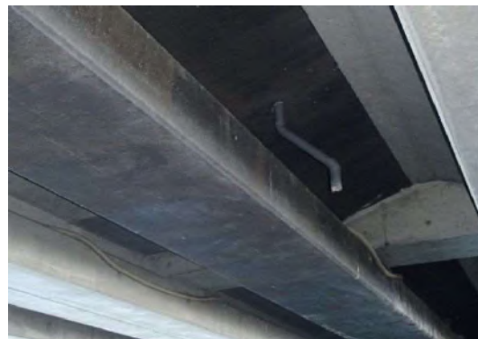
写真-6.5.1 チタン溶射方式（No. 1 回路）※後施工
