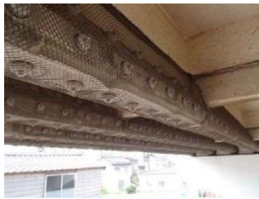
図-1.3.3 流電陽極方式方式の概要
