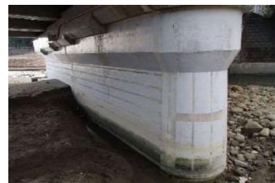
P1 橋脚の状況
