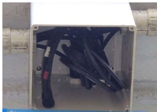
写真-3.4.1 山側プルボックス（配線集中箇所）
