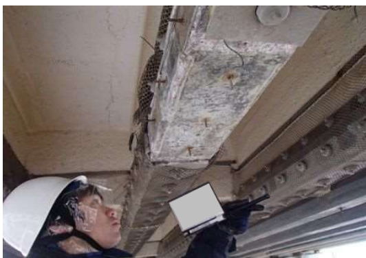
写真-5.1.3 コンクリート表面確認
