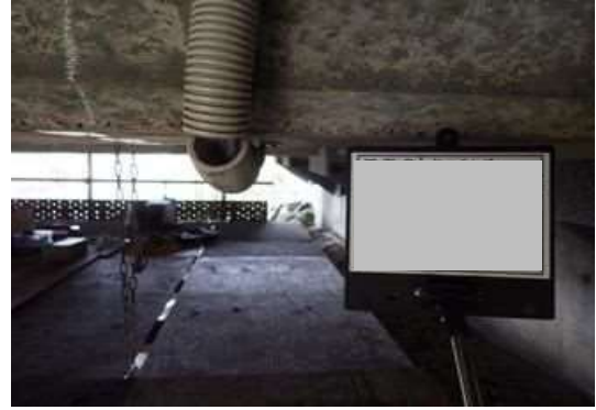
写真-3.7.1 配管材（PF 管）の損傷
