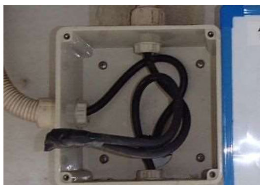
写真-3.4.2 海側プルボックス（端部分岐箇所）
