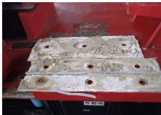
写真-5.1.2 亜鉛防食板撤去完了
