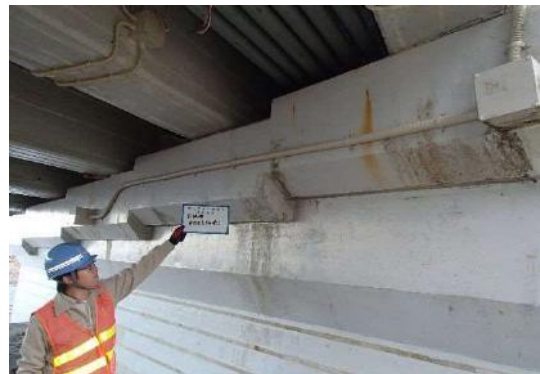
写真-3.3.2 橋脚部配管復旧確認
