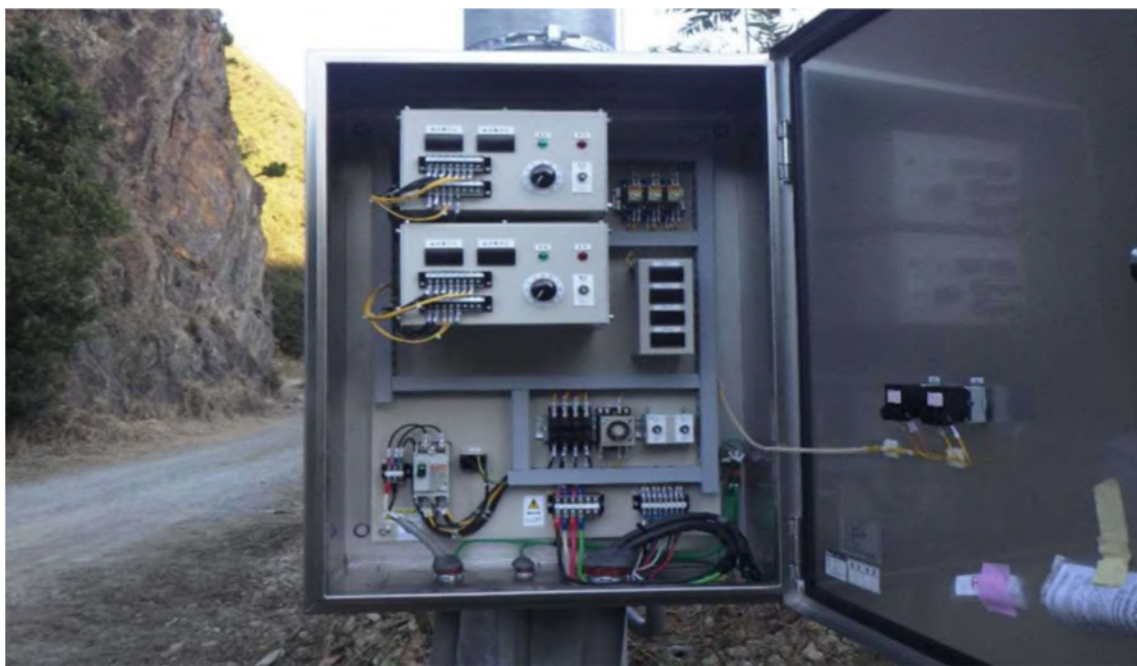
写真-3.3.20 チタンロッド方式 (東興ジオテック)
