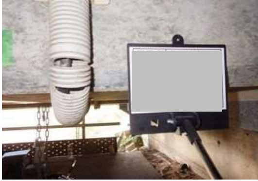
写真-3.7.1 配管材（PF 管）の損傷
