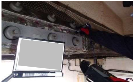
写真-5.2.1 既設防食板周囲オン電位測定
