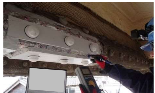
写真-5.2.2 代替防食板周囲オン電位測定
