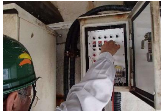
写真-4.5.3 直流電源装置及び流電モニタリングボックス
