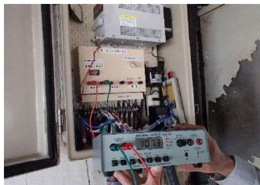
写真-3.5.2 流電陽極方式測定状況
