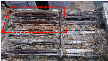
ハツリ完了時 赤囲み部分は断面修復材のはく離・はく落 が顕著であった部分。
