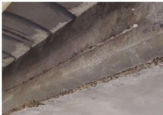
写真-3.5.7 チタンロッド方式 (電流分配材被覆モルタルの変状)
