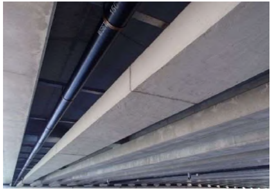
写真-6.5.5 チタンメッシュ方式 (No. 5 回路) ※後施工
