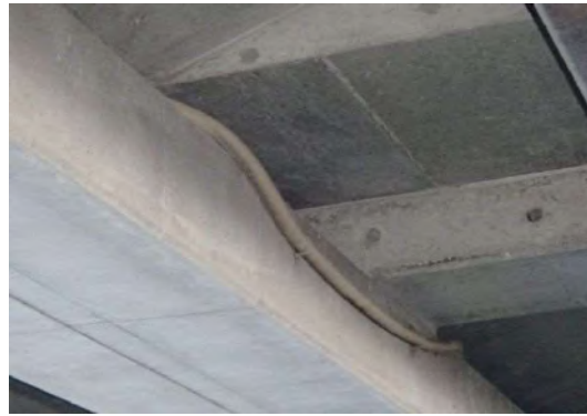
写真-6.5.2 チタングリッド方式（No. 2 回路）※先施工
