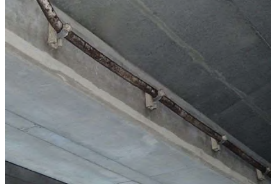
写真-6.5.3 チタンロッド方式 (No. 3 回路) ※先施工
