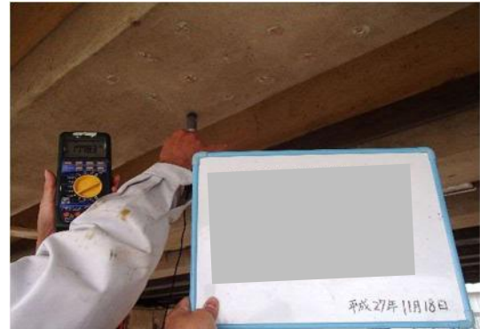
写真-3.7.2 チタンメッシュ健全部測定状況
