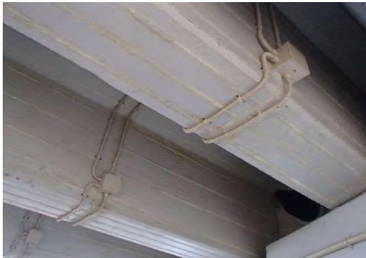
写真-3.3.1 主桁・床版配管状況
