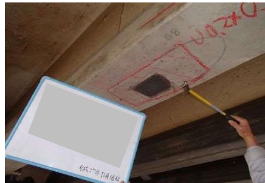
写真-3.1.6 たたき点検状況
