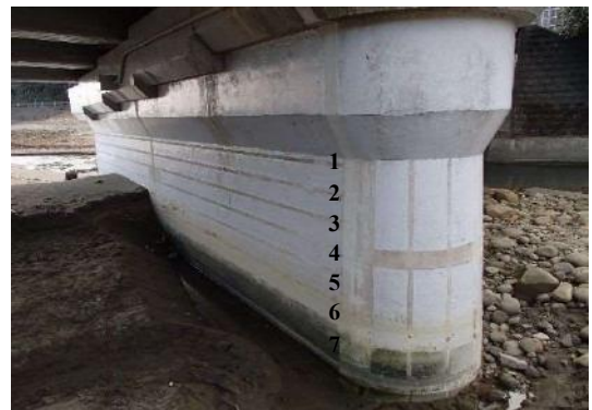
写真-1.4.2 P1 橋脚気中部・干満部
