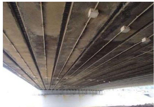
写真-3.5.6 チタン溶射方式
