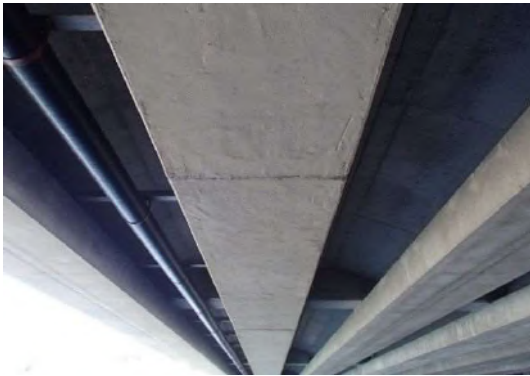
写真-6.5.5 チタンメッシュ方式 (No. 5 回路) ※後施工
