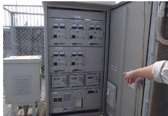
写真-6.5.6 直流電源装置, 遠隔モニタリングシステム
