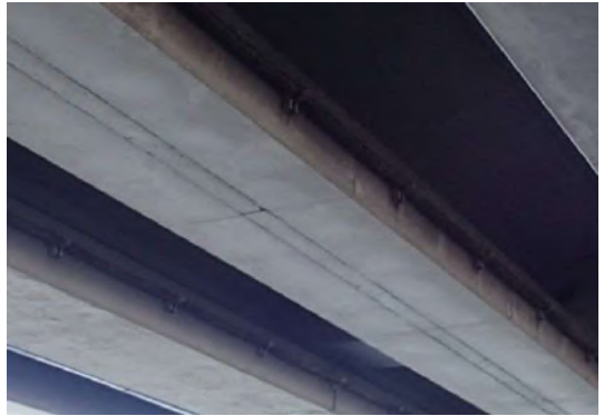
写真-6.5.4 チタンリボンメッシュ方式 (No. 4 回路) ※先施工
