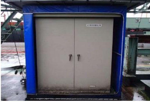
写真-4.4.8 専用波避けシートによる設置例
