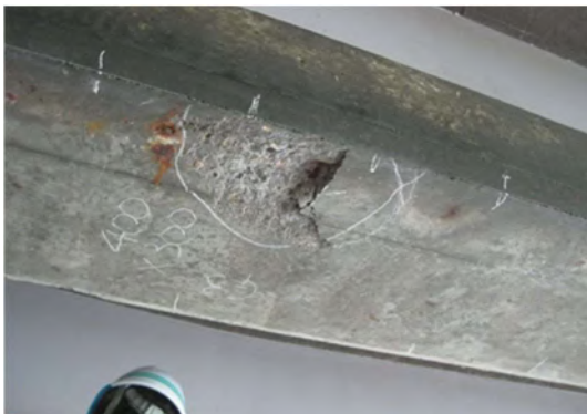
写真-1.5.1 G3桁の外観状況（第2径間）
