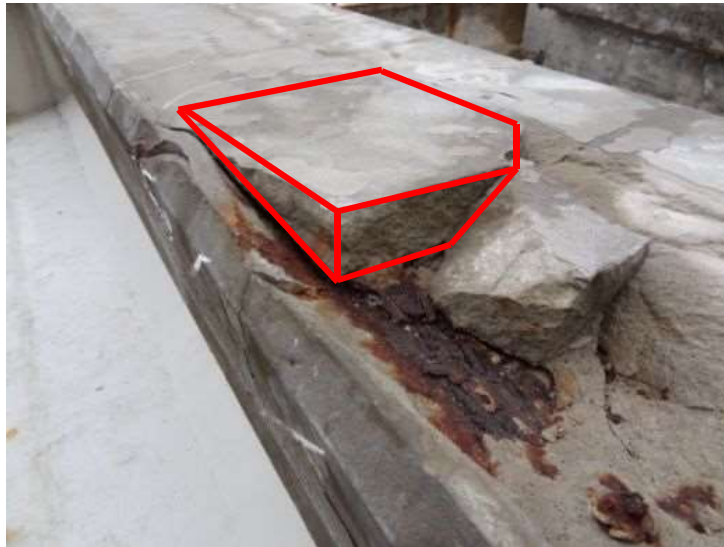
写真-3.2.4 断面修復材の採取位置（赤線で囲んだ部分を採取）
