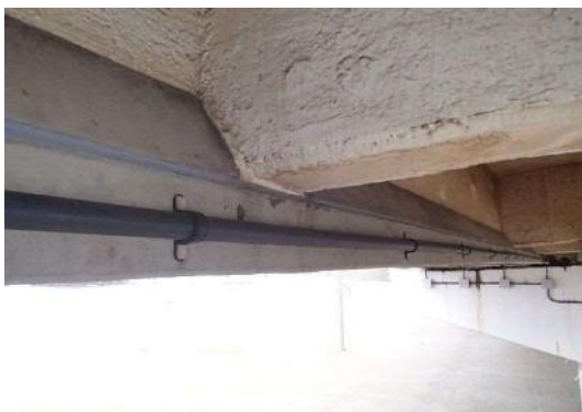
写真-3.3.1 チタンメッシュ方式 (直線部配管状況)
