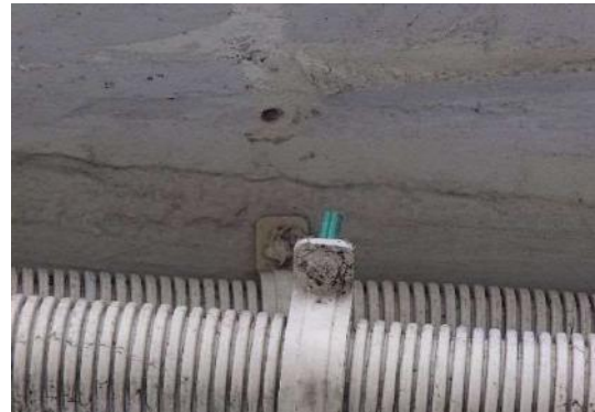
写真-3.3.6 樹脂プラグ抜け落ち
