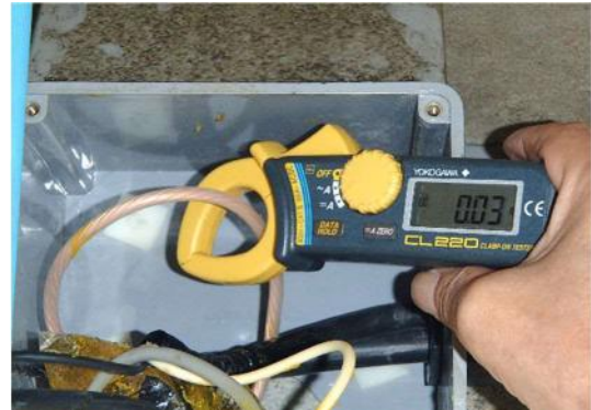
写真-3.9.2 電流測定状況
