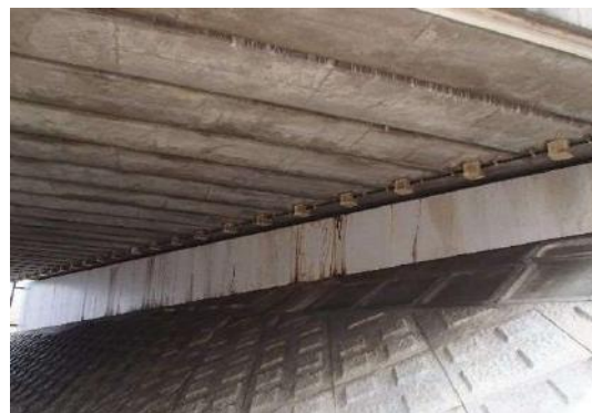
写真-3.5.14 桁端部状況
