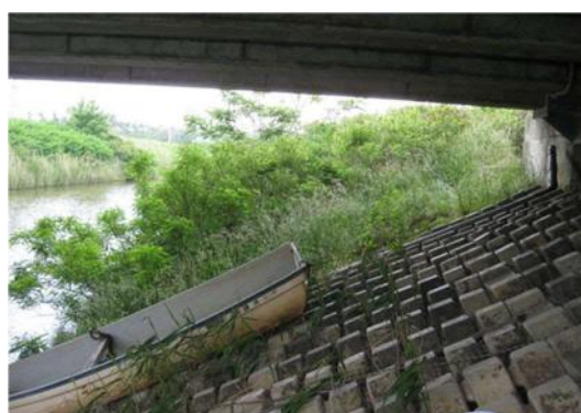
写真-1.5.6 桁下の状況
