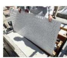
ECPパネル(面状陽極(チタンメッシュ)) ECPパネル(網状陽極(チタンリボンメッシュ))
