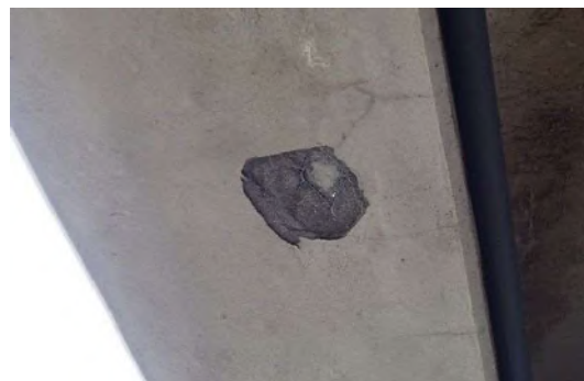
写真-4.5.1 チタンメッシュ方式陽極被覆モルタル剥落部（G1 桁底面）
