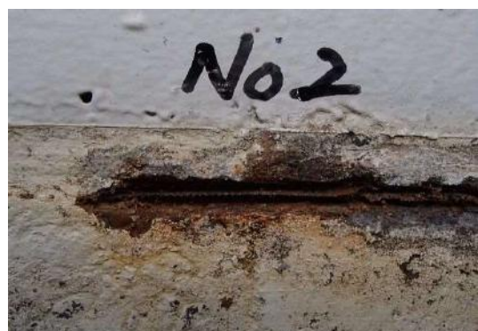
写真-3.1.8 P1 橋脚 A2 側 (6 段目陽極)
