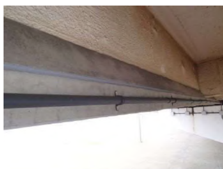
写真-3.3.8 電線管設置例
