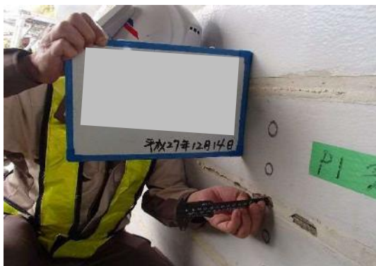
写真-3.1.5 陽極かぶり厚確認状況
