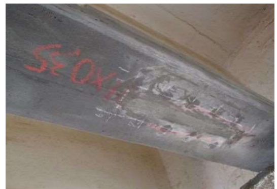
写真-4.1.4 モルタル被覆完了
