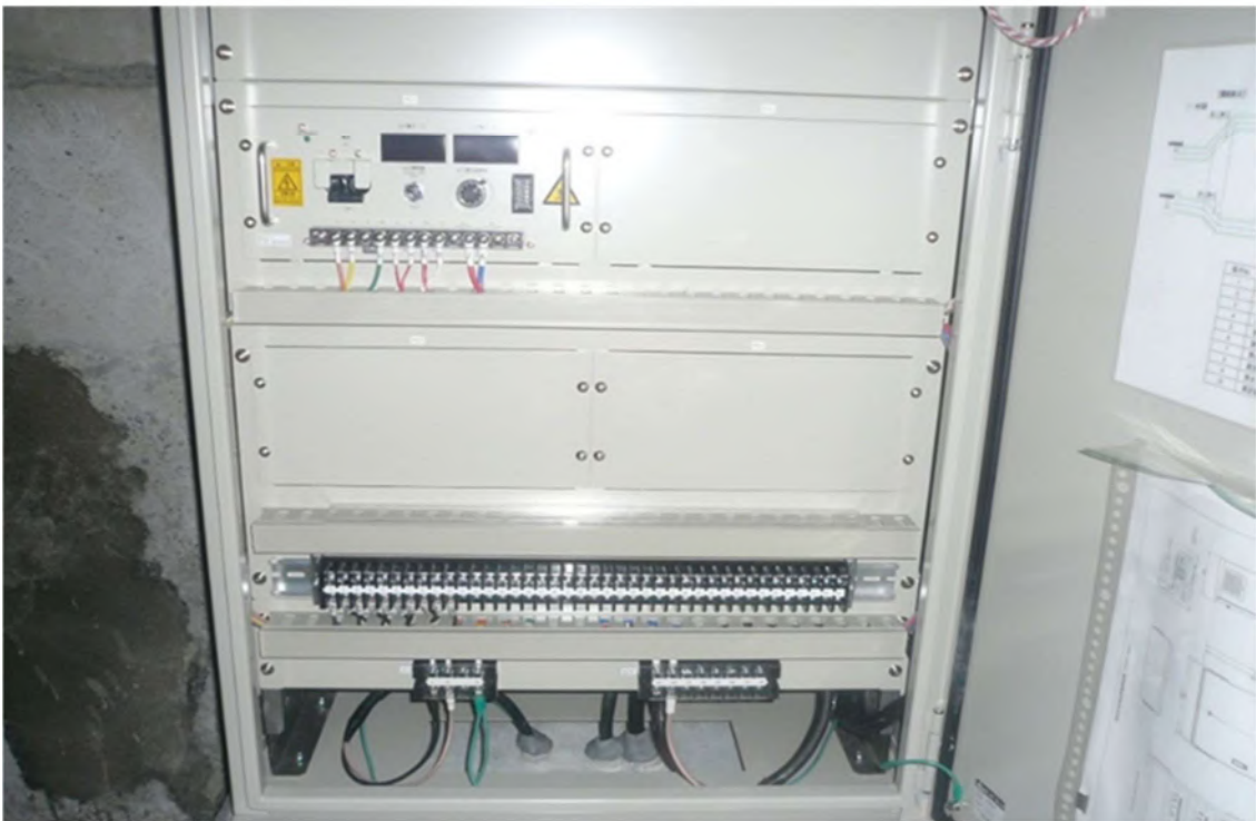
写真-3.3.18 貼付け型モール陽極方式（ショーボンド建設）
