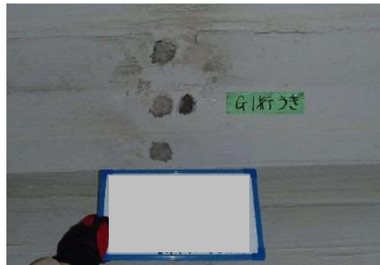
写真-3.7.2 G1桁ケレン完了
