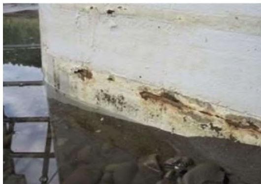
写真-5.2 A2橋脚没水部状況
