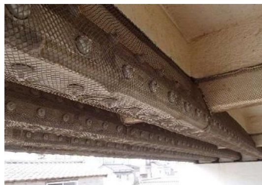
写真-4.5.2 流電陽極方式部養生ネット設置状況（G8～G11 桁）
