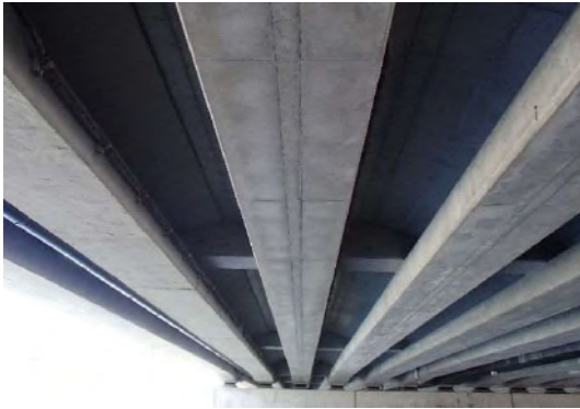
写真-6.5.4 チタンリボンメッシュ方式 (No. 4 回路) ※先施工
