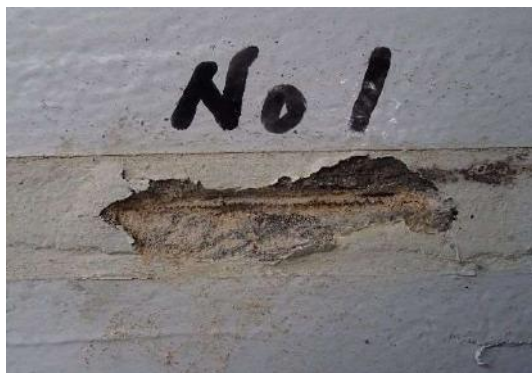
写真-3.1.7 P1 橋脚 A2 側 (4 段目陽極)
