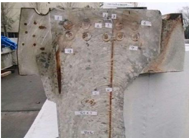
写真-3.1.3 G5-3における鉄筋間導通確認試験
