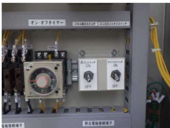
写真-3.3.15 ONOFF タイマー+デジタル表示パネル
