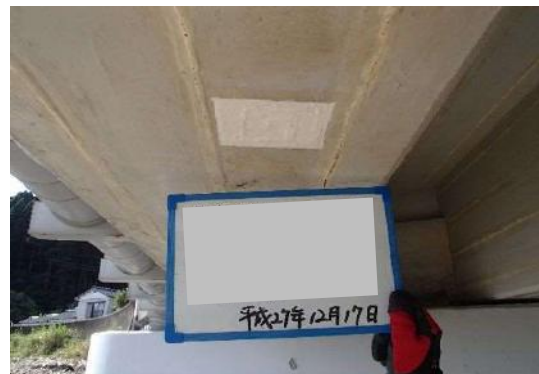
写真-3.1.14 はつり部復旧完了
