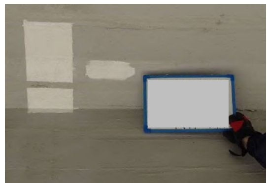
写真-3.7.6 G1桁表面被覆復旧完了
