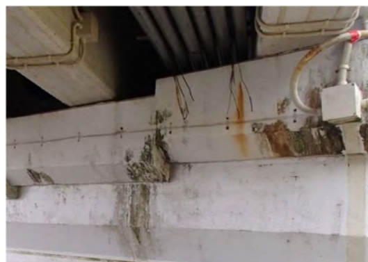
写真-5.5.6 配管材の脱落（P1橋脚A1側）
