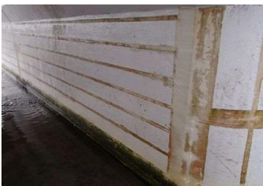
写真-3.1.3 P1 橋脚 (A1 側)
