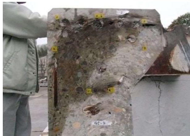
写真-3.1.4 G5-4における鉄筋間導通確認試験
