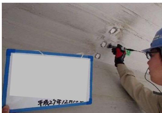
写真-3.7.5 G1桁表面電位測定状況
