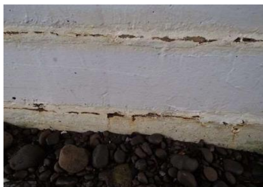
写真-3.1.4 P1 橋脚 (A2 側)
