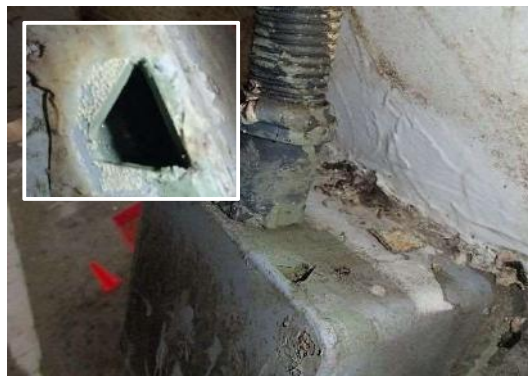
写真-3.4.2 チタングリッド方式（樹脂充填）
