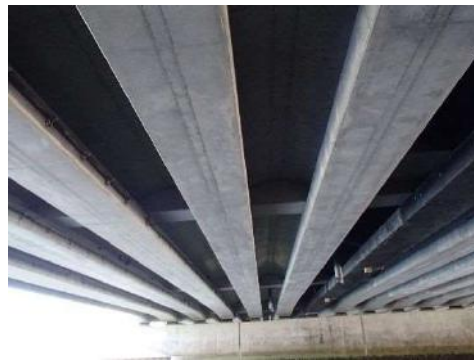
電気防食対象(桁下面)
