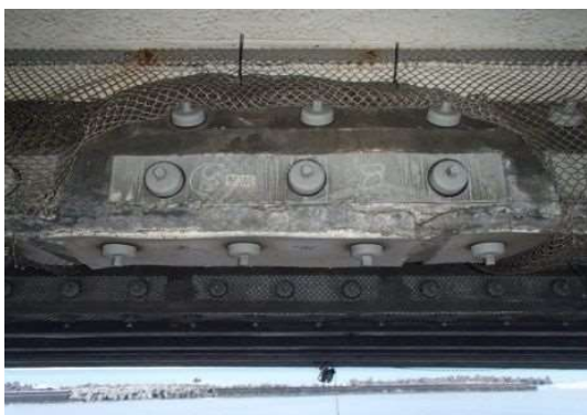
写真-5.1.1 既設防食板（亜鉛シート）
