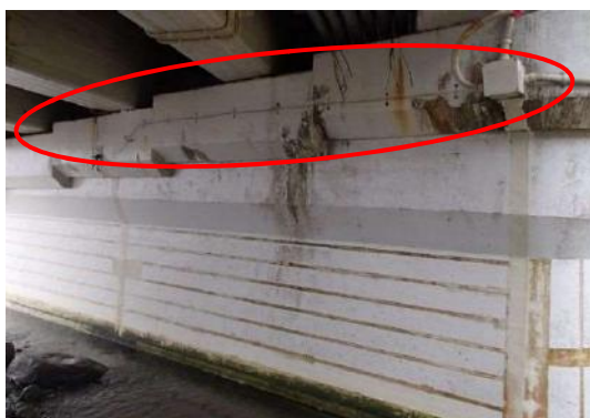
写真-5.5.6 配管材の脱落（P1橋脚A1側）
