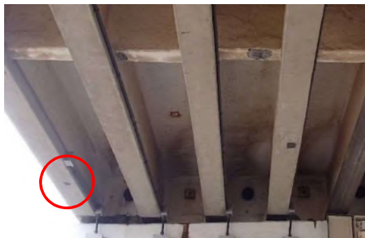
写真-4.5.1 チタンメッシュ方式陽極被覆モルタル剥落部（G1 桁底面）
