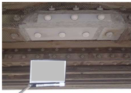
写真-5.1.4 代替防食板設置完了
