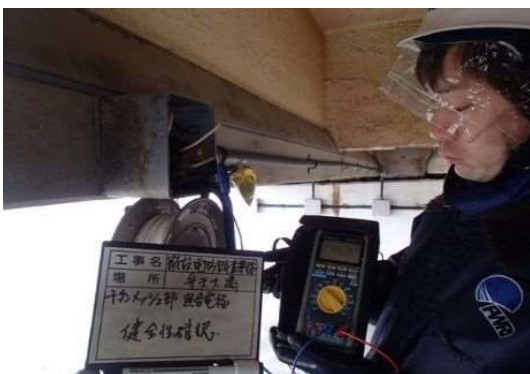
写真-6.2.2 電位値確認状況
