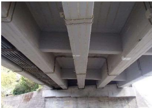
写真-1.4.1 A1-P1 主桁部・床版部
