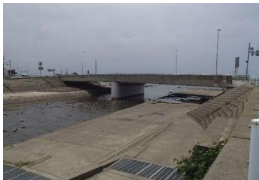
写真-3.5.13 Y橋全景
