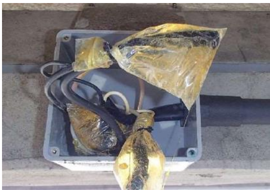
写真-3.4.1 チタンメッシュ方式結線部
