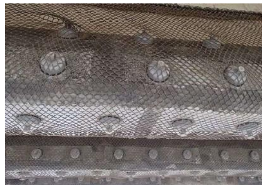
写真-4.5.2 流電陽極方式部養生ネット設置状況（G8～G11 桁）
