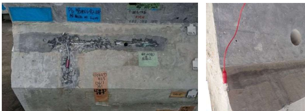
写真-3.2.1 圧着端子 2 (G5-2 桁) 付近のハツリ状況 (左 : ハツリ後, 右 : ハツリ前)
