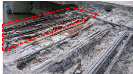
ハツリ完了時 赤囲み部分は断面修復材のはく離・はく落 が顕著であった部分。
