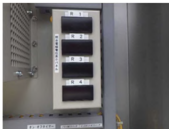
写真-3.3.15 ONOFF タイマー+デジタル表示パネル
