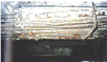
桁電気防食施工前 (G5 桁) (平成 10 年度荒磯橋他 24 橋調査設計業務報告書より)
