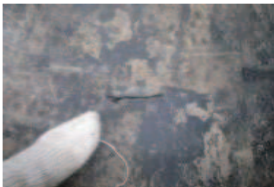
写真 2.1.6 流下物による損傷状態
