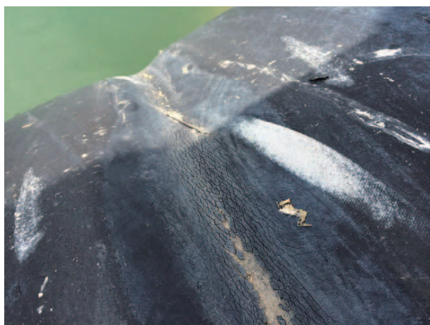
写真 2.2.22 カバーゴムのオゾンによるひび割れ
