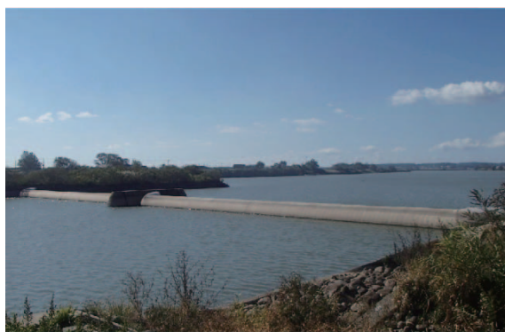
写真 2.1.11 起立状況 (上流側→下流側)
