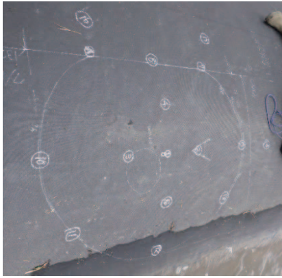
写真 3.1.7 ゴム堰上部外観
