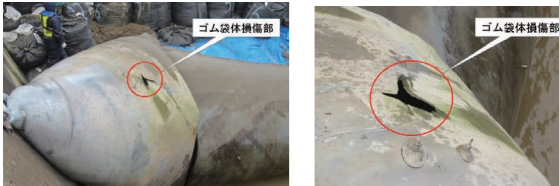
写真 2.1.9 コンクリート躯体との擦れによる摩耗損傷（右写真：拡大図）
