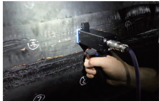
写真 3.1.10 ゴム堰内部側面打音測定状況
