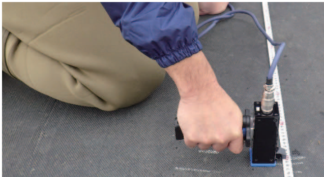
写真 3.1.9 ゴム堰上部打音測定状況
