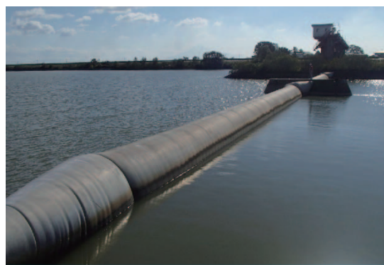
写真 2.1.12 起立状況 (右岸側→左岸側)
