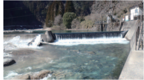
写真 2.1.25 ゴム袋体全景
