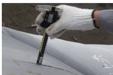
写真2.1.22 亀裂深さの計測
