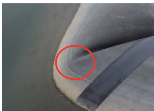
写真 4.1.2 法尻の折れジワ頂点
