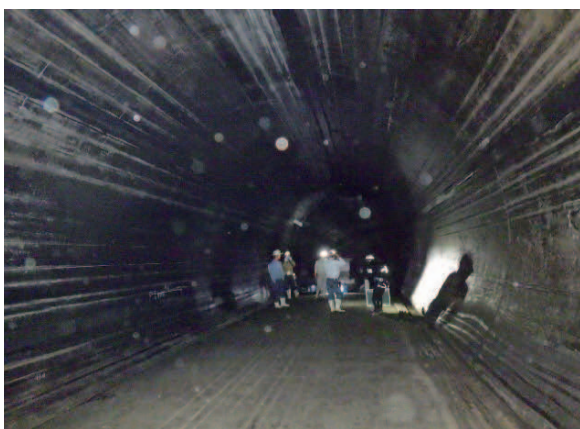
写真 3.1.5 ゴム堰内部状況
