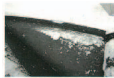
写真 2.1.28 右岸法部のフィン
