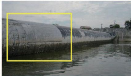
写真 2.2.15 延命補修事例
