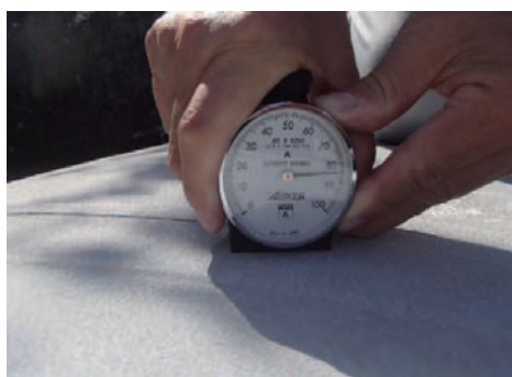
写真 2.1.17 外層ゴムの硬度計測（中央部=84）
