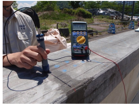
写真-5.4.2.4 表面電位測定状況
