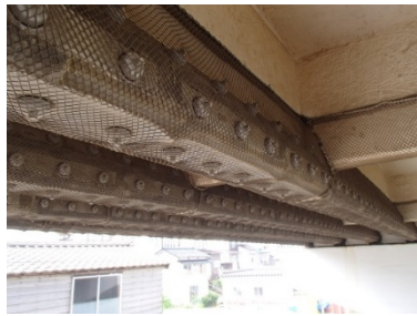
図-3.1.4 流電陽極方式の概要
