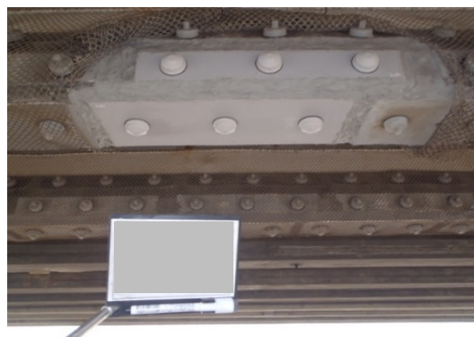
写真-4.5.4 代替防食板設置完了
