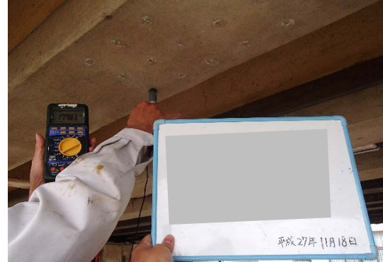
写真-3.3.22 チタンメッシュ健全部測定状況
