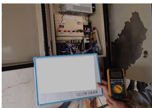
写真-3.3.19 外部電源方式測定状況
