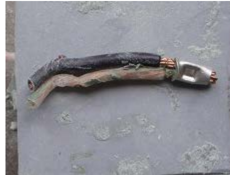
写真-5.4.5.4 排流端子と電線の結線
