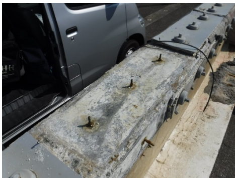
写真-5.5.3.1 陽極撤去後ブロック⑪
