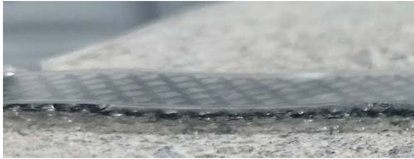
図-2.2.3 チタンリボンメッシュ陽極のハイドロゲルを用いた設置の例
