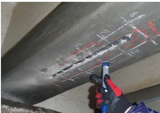
写真-4.4.3 表面電位測定状況
