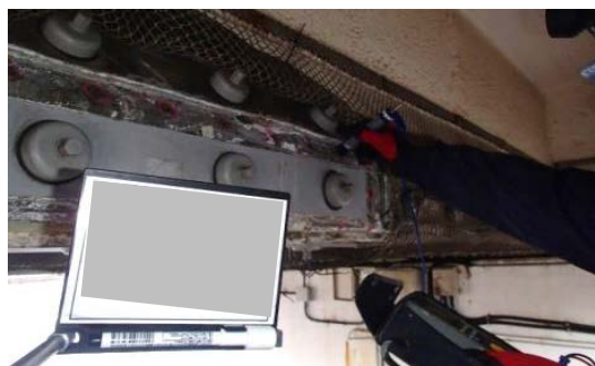
写真-4.5.5 既設防食板周囲オン電位測定
