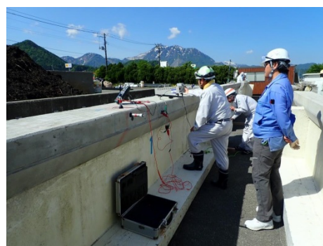
写真-5.3.2.3 表面電位測定状況
