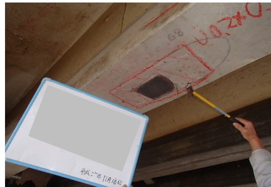
写真-3.3.6 たたき点検状況
