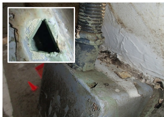
写真-3.3.16 チタングリッド方式（樹脂充填）
