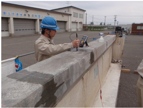
写真-5.4.2.3 表面電位測定状況
