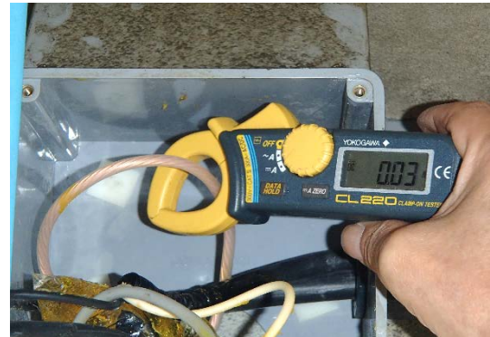
写真-3.3.24 電流測定状況
