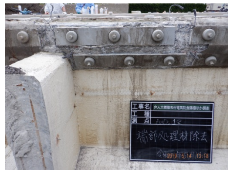
写真-5.5.2.4 間詰パテ撤去後ブロック⑫
