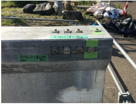
写真-5.4.3.1 付着試験用治具接着状況
