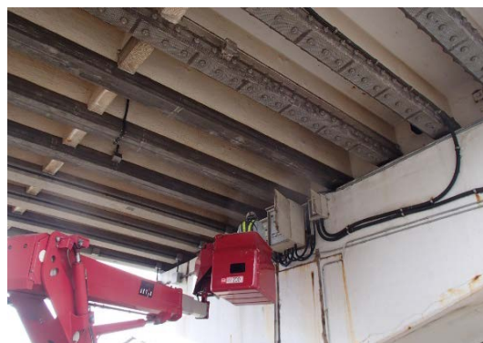
写真-2.5.6 高所作業車による調査状況
