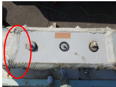
写真-5.5.4.2 建研式試験箇所詳細
