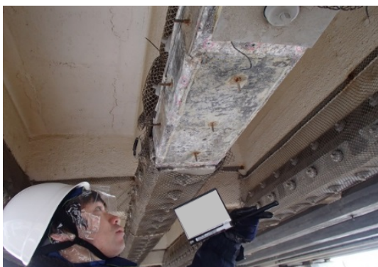
写真-4.5.3 コンクリート表面確認
