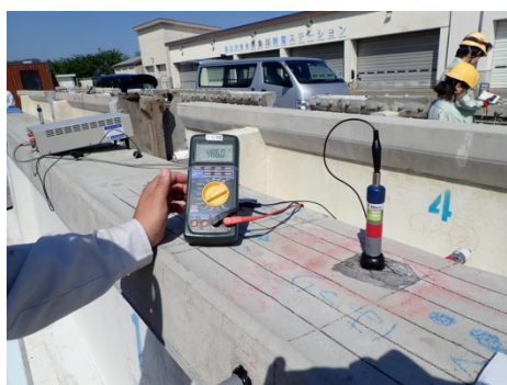
写真-5.3.2.2 表面電位測定状況
