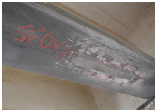
写真-4.4.4 モルタル被覆完了
