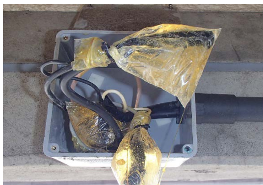
写真-3.3.15 チタンメッシュ方式結線部
