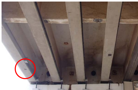
写真-2.5.1 チタンメッシュ方式陽極被覆モルタル剥落部（G1 桁底面）
