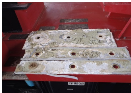
写真-4.5.2 亜鉛防食板撤去完了
