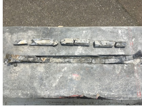
写真-5.4.4.2 ブロック⑨ (富山側)
