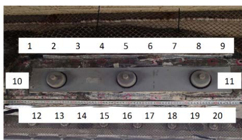
図-4.5.1 山側側面防食板測定位置 (20点)
