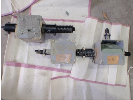
写真-5.4.5.1 解体前のプルボックスの状況
