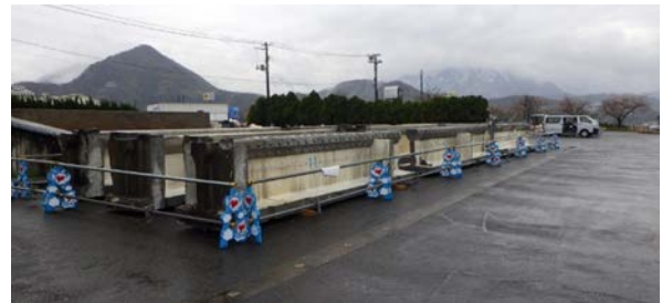
写真-5.2.2 調査桁配置状況
