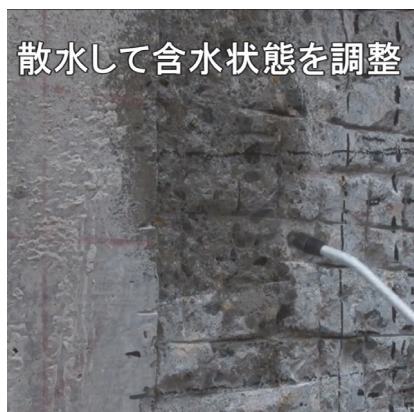
図3-2 はつり面での含水状態の調整の例
