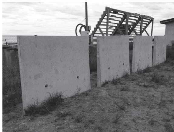
写真-1 暴露試験場への設置状況
