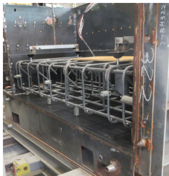
b) 配筋の状況
