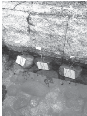
写真-5 せせらぎ水路Aにおけるタイル設置状況
