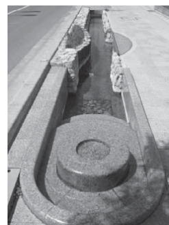
写真-2 せせらぎ水路 B
