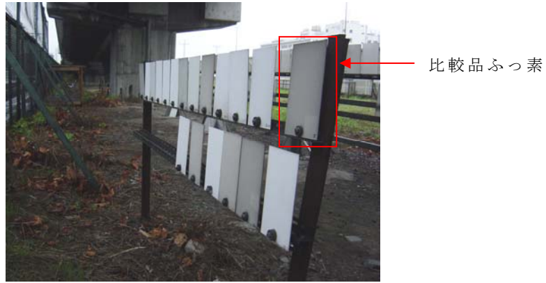
写真4.4.1-1 第1回東京雨なし暴露状況（暴露25ヶ月後） （IV種第1回暴露試験：東京雨なし）
