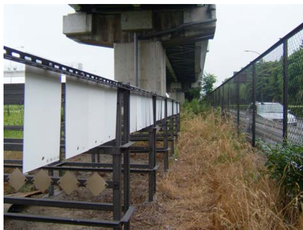
写真4.4.2-1 第2回東京雨なし暴露状況（暴露1ヶ月後） (IV種第2回暴露試験：東京雨なし)
