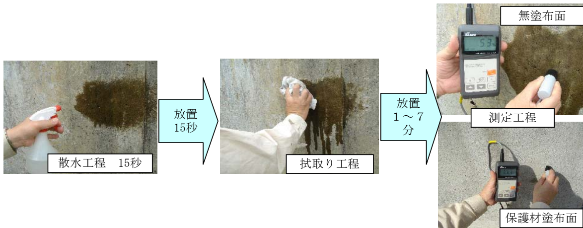
図-IV.2.14 測定状況
