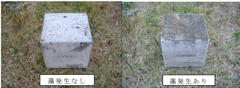
写真-IV. 2. 1 つくば暴露7年の試験体体外観
