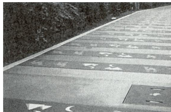
軽量骨材を利用した透水床板
