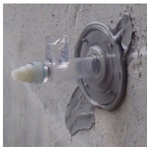
写真-1 注入器とシール材のサンプル設置の例
