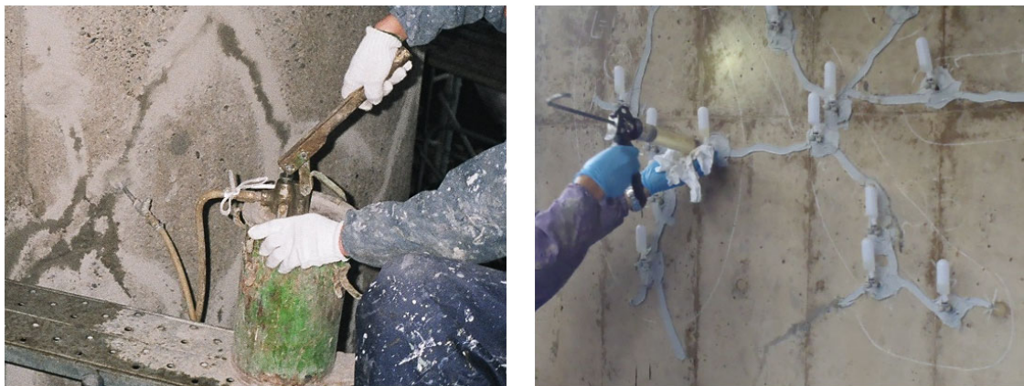
解説 写真-2.3.1 ひび割れ注入工法の施工例
