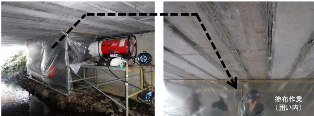
写真 26-1 施工現場の様子
