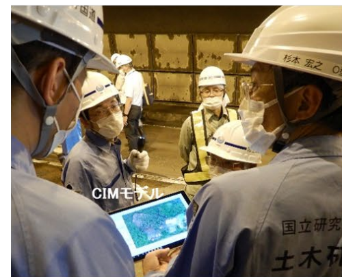
地すべりとトンネル位置の確認
