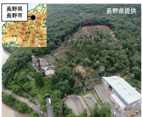
地すべり全景
