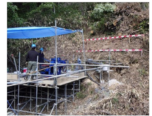
地下水排除工(長野県)
