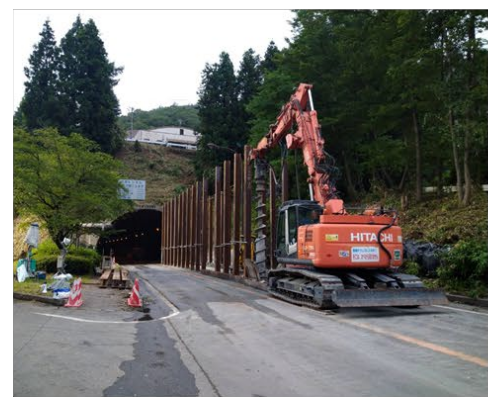
国道19号の対策(長野国道)
