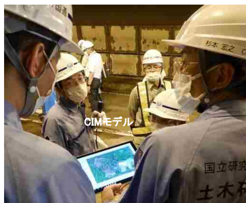
地すべりとトンネル位置の確認
