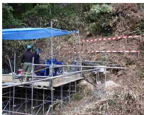
地下水排除工(長野県)
