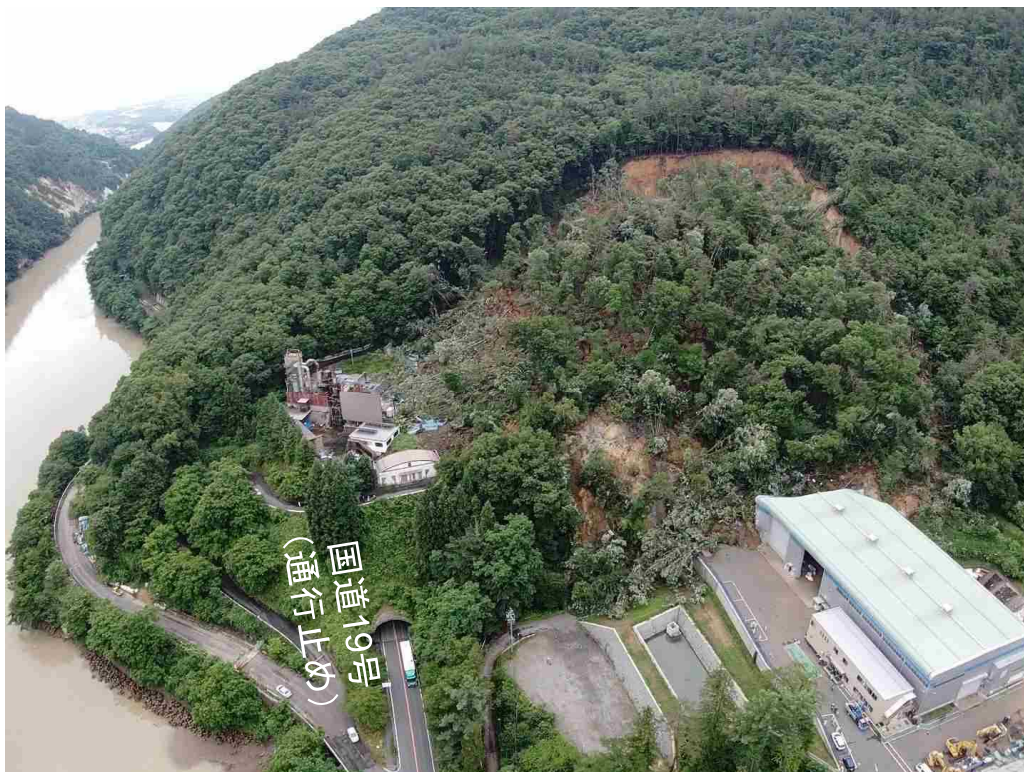
国道19号長野市篠ノ井小松原地区
