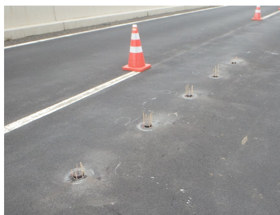
(b) 大平高架橋の固定状況
