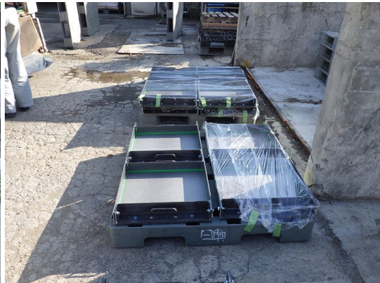
写真-2.1.2 型枠設置・養生 (3)
