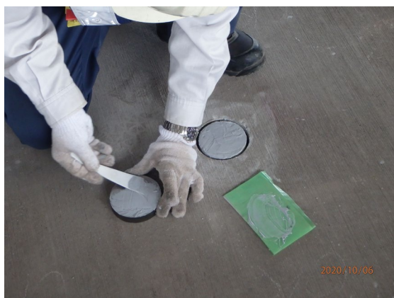
写真-4.2.6 治具用接着剤の塗布状況
