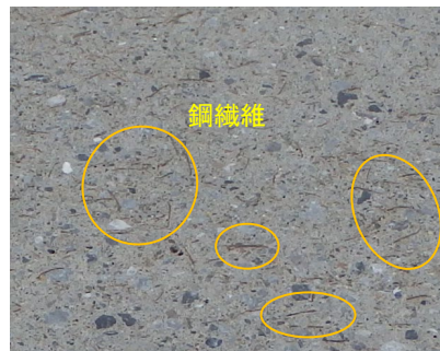
写真-4.3.1 鋼繊維の状態 (SFRC 舗装路面)
