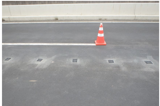
(b) 大平高架橋
