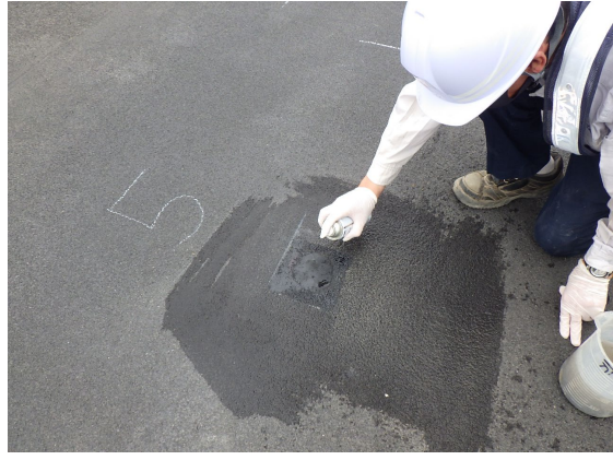
写真-4.2.14 スプレーによる施工
