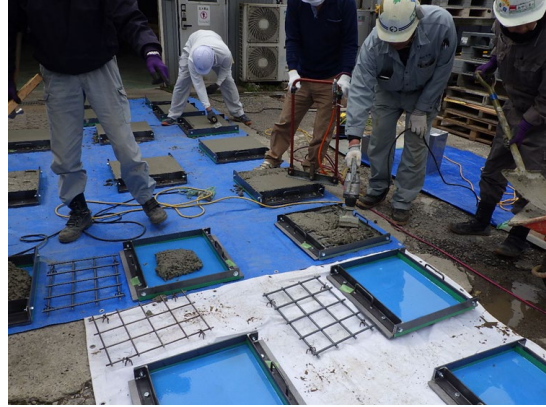
写真-2.1.8 振動機による施工 (⑦)
