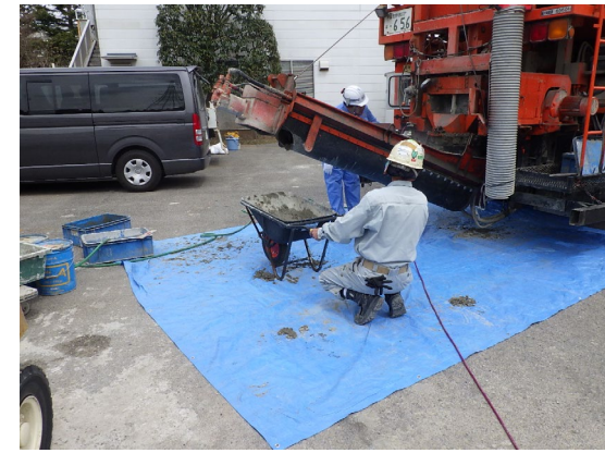
写真-2.1.4 SFRC練り落とし状況 (5)
