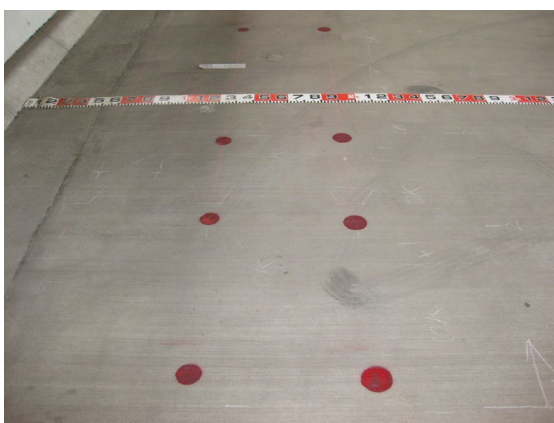
(a) 横浜ベイブリッジのマーキング
