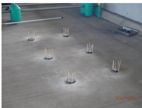
(a) 横浜ベイブリッジの固定状況
