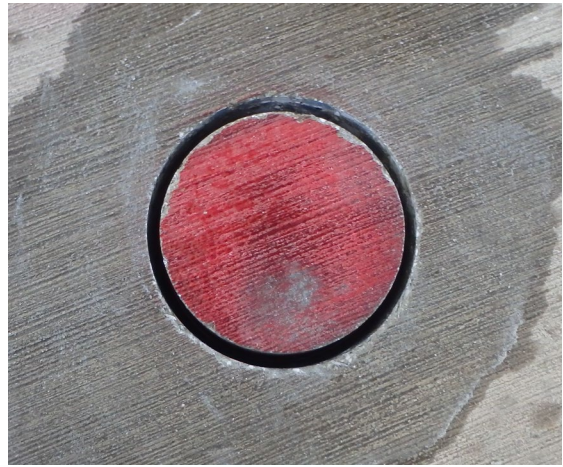
写真-4.2.3 切削状況（横浜ベイブリッジ）
