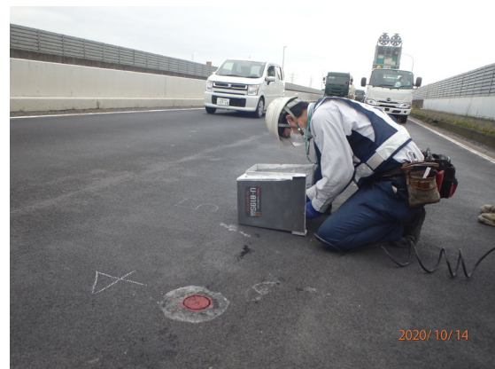
(b) 大平高架橋の研掃状況
