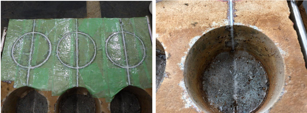
写真-2.1.18 ひび割れ注入後の充填状況の確認
