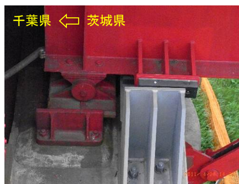
(f) 鉸桁の鋼製ピンローラー支承 (茨城県側)
