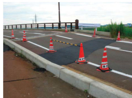
図-6.1.17 背面段差の補修
