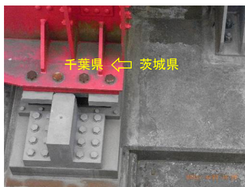
(e) ランガー桁の積層ゴム支承 (千葉県側)
