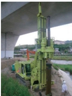
図-5.3.1 回転杭工法による桁下施工例 8)
