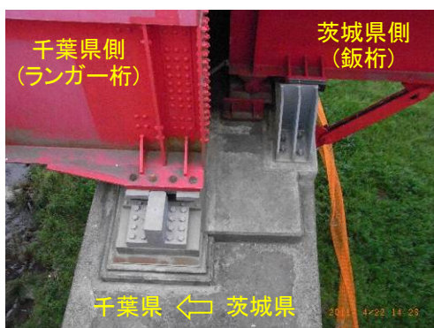
(c) P 6 橋脚架け違い部
