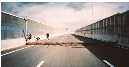
図-1.1.3 1995年1月17日兵庫県南部地震で生じた周辺地盤の流動化に起因する支承周辺の損傷例 4), 5)
