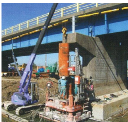
図-5.3.2 中掘り杭工法による桁下施工例 9)
