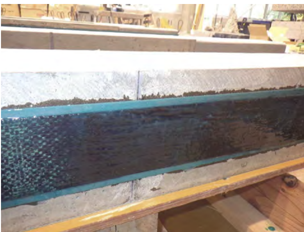
(e) 連続繊維シート施工
