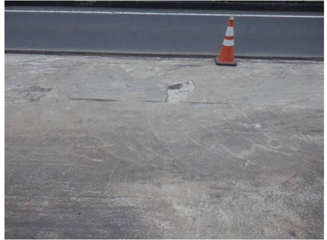
(b) 床版上面（下り側舗装除去時）
