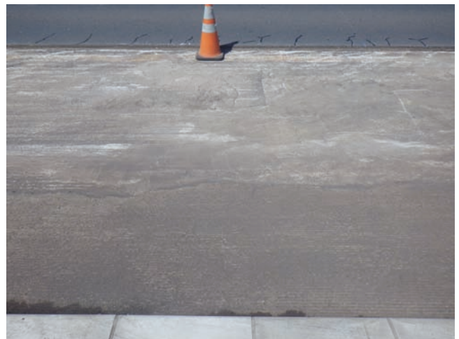
(b) 床版上面（下り側舗装除去時）
