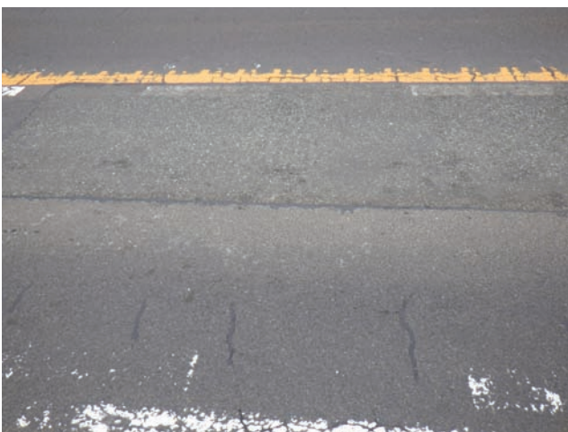
(a) 舗装の補修
