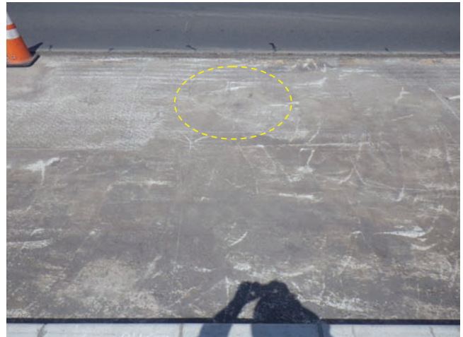
(b) 床版上面（下り側舗装除去時）
