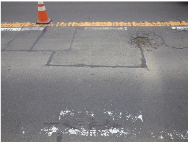
(a) 舗装の補修
