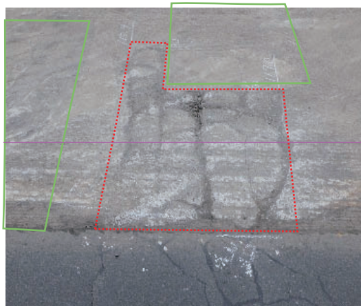
(a) 床版上面写真（舗装撤去後）
