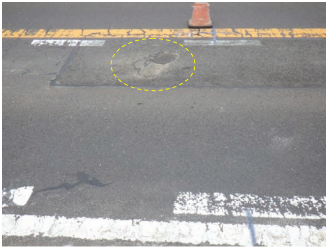
(a) 舗装の補修
