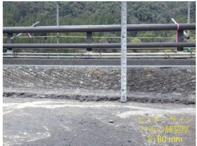
図-4.1.19 センターライン付近の舗装厚 (A1-P1 間, A1 から 34m 付近)
