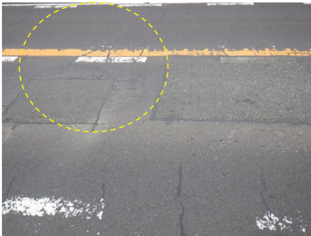
(a) 舗装の補修
