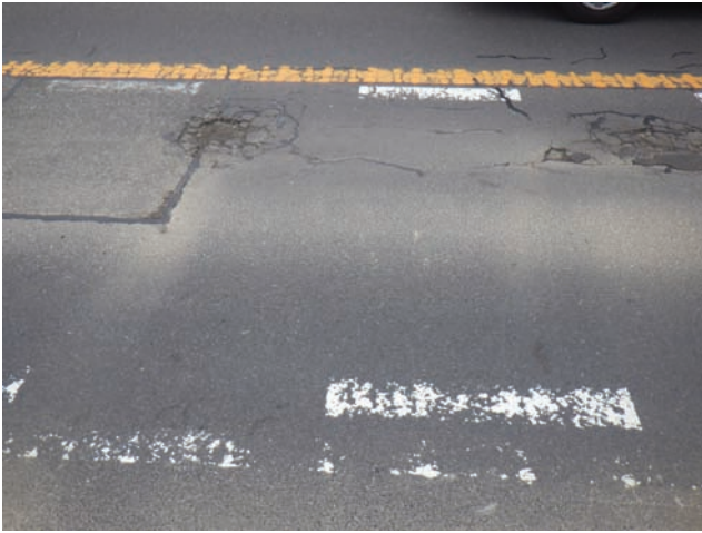
(a) 舗装の補修
