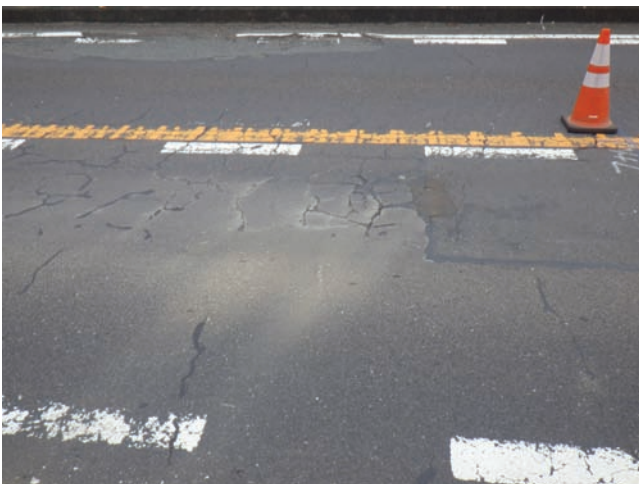
(a) 舗装の補修
