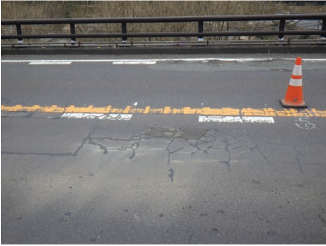
(a) 舗装の補修
