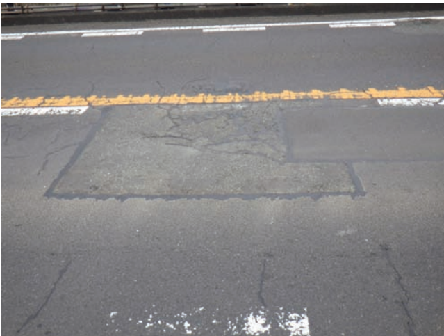
(a) 舗装の補修
