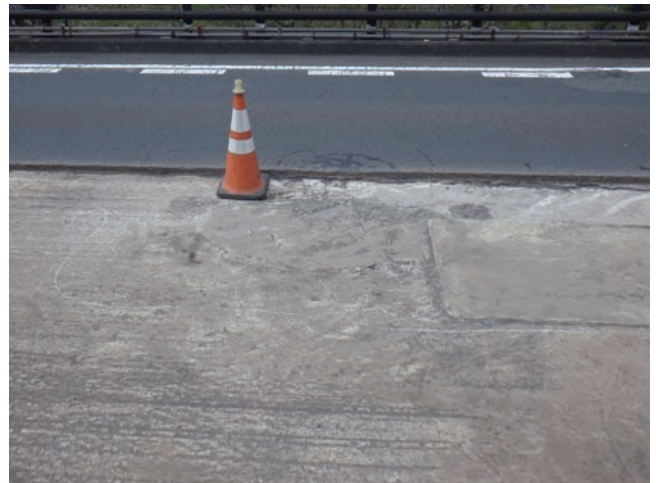
(b) 床版上面（下り側舗装除去時）
