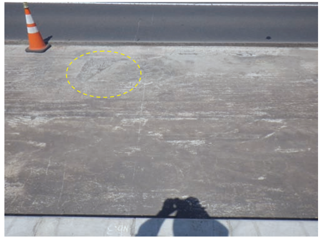
(b) 床版上面（下り側舗装除去時）
