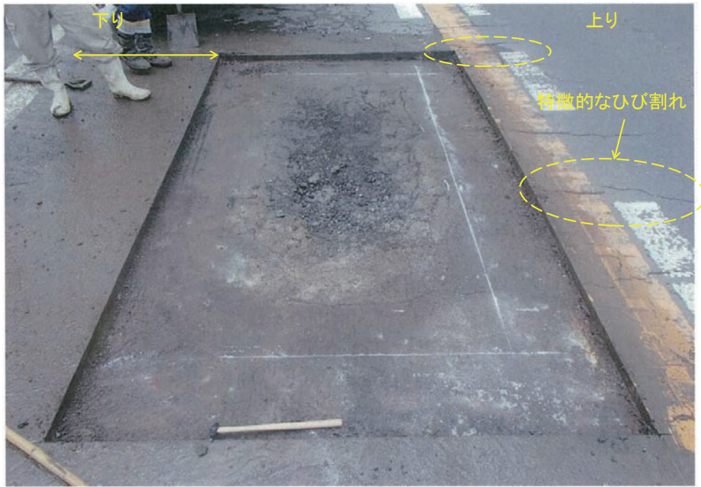
(a) 補修直前の床版上面, 2015年9月
