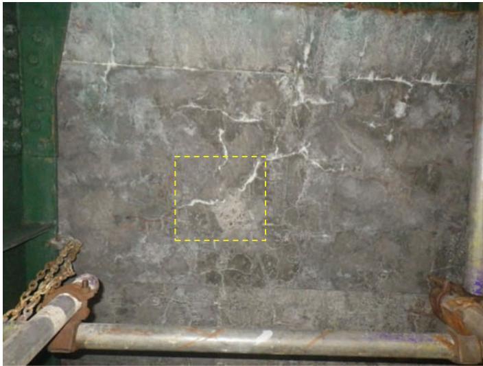
(a) 床版下面のポップアウトの例（右は黄色破線枠の範囲を拡大）
