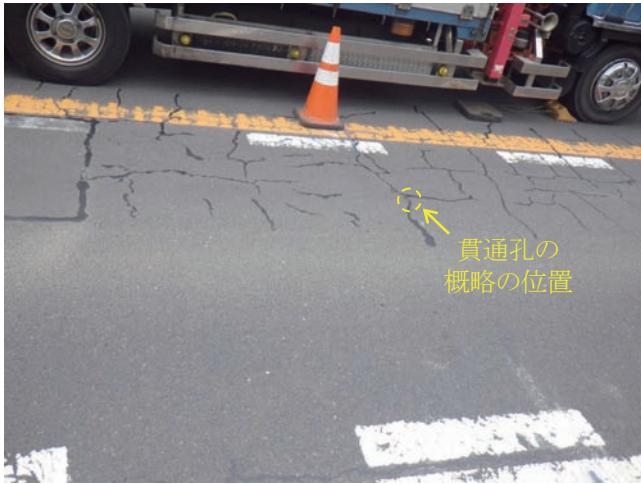
(a) 舗装の補修
