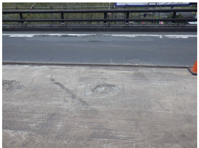
(b) 床版上面（下り側舗装除去時）
