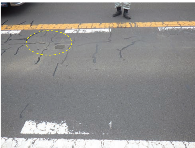
(a) 舗装の補修
