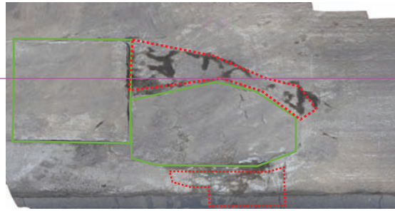
(a) 床版上面写真（舗装撤去後）
