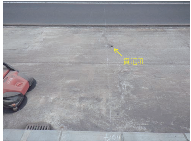
(b) 床版上面（下り側舗装除去時）
