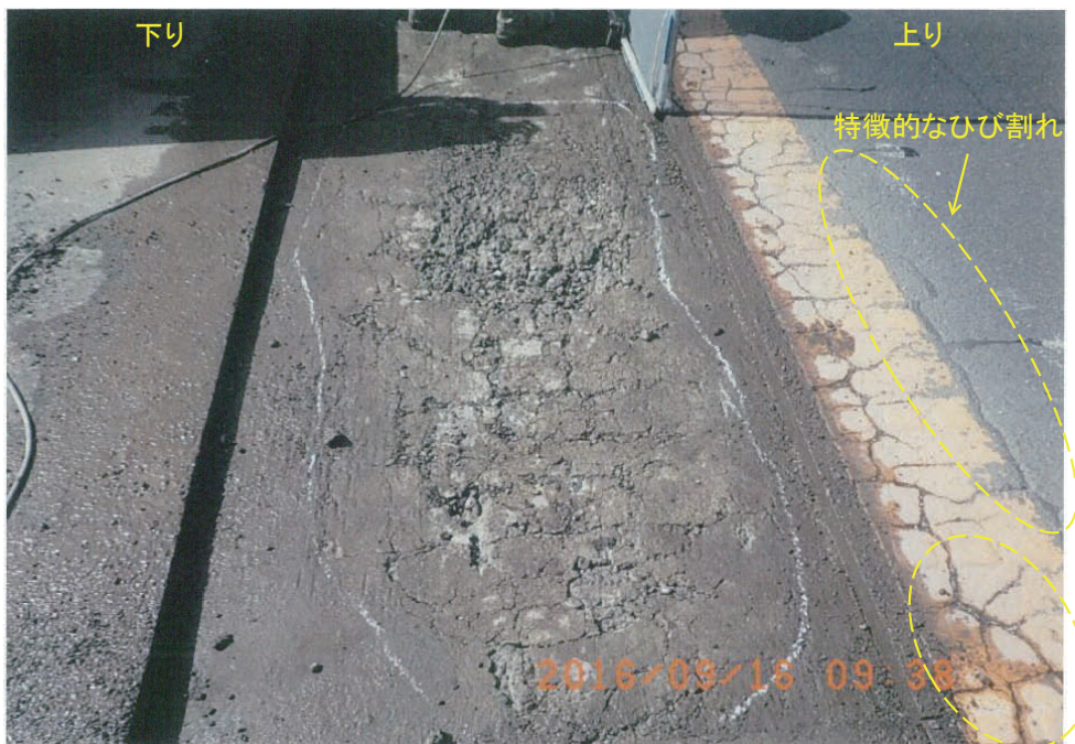
(a) 補修直前の床版上面，2016年9月
