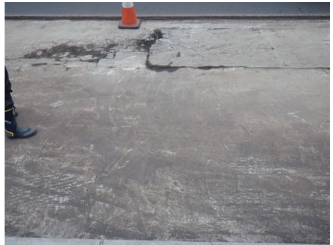
(b) 床版上面（下り側舗装除去時）
