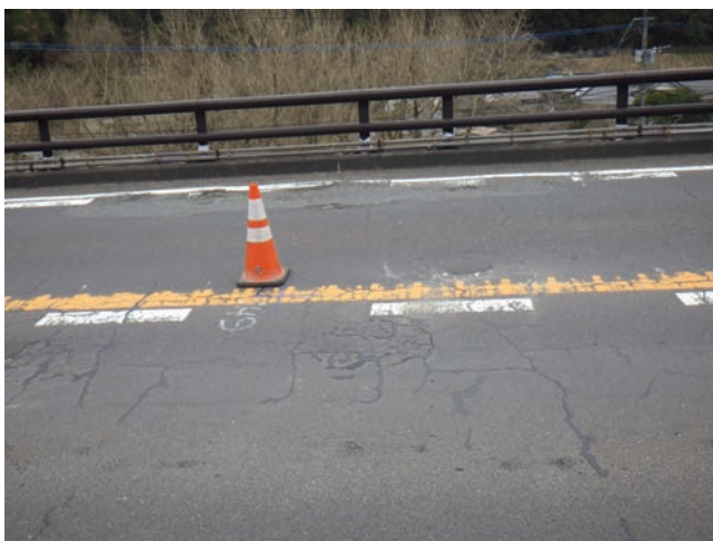
(a) 舗装の補修
