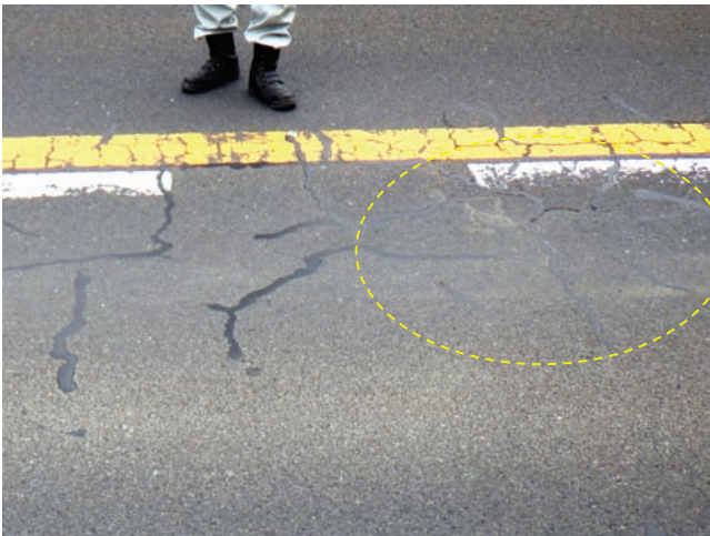
(a) 舗装の補修
