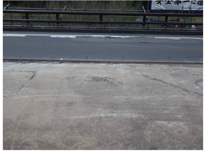
(b) 床版上面（下り側舗装除去時）
