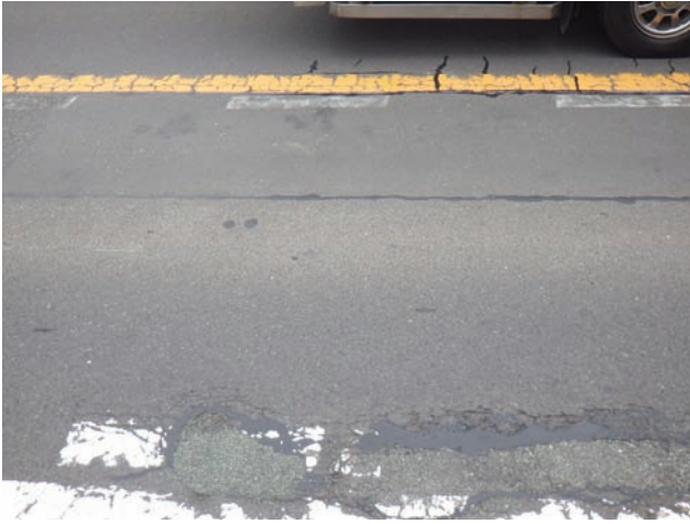
(a) 舗装の補修
