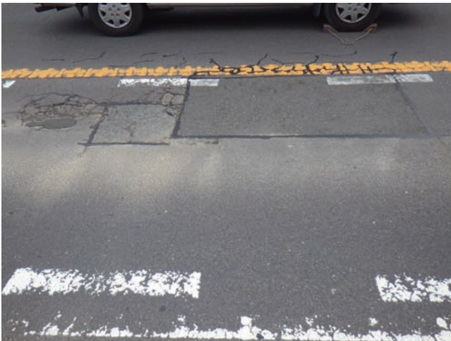
(a) 舗装の補修
