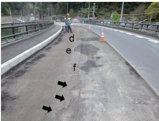
図-4.4.5 電磁波レーダのタイムスライス断面、床版上面写真、及び、床版上面の滞水の様子 (2)
