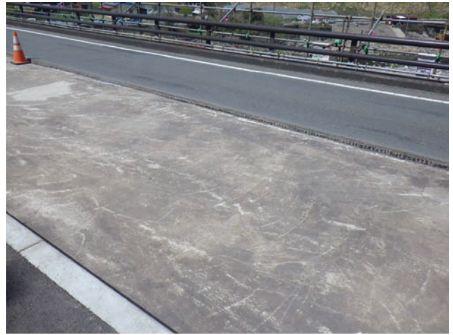
(b) 床版上面（下り側舗装除去時）
