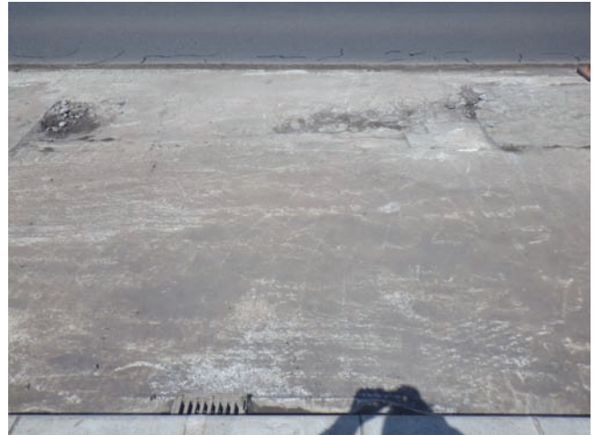
(b) 床版上面（下り側舗装除去時）
