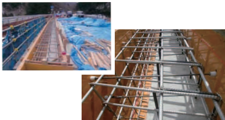
写真-9.5 地覆鉄筋 SUS 鉄筋配置
