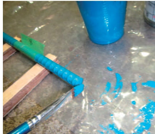
写真-5.5 切断面のタッチアップ
