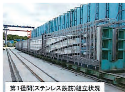
写真-9.1 SUS 鉄筋組立状況
