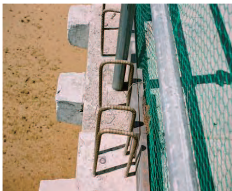
写真-9.4 地覆埋込鉄筋 SUS 鉄筋配置
