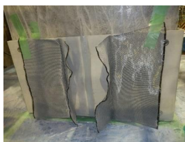
① 炭素繊維シートの仮止め
