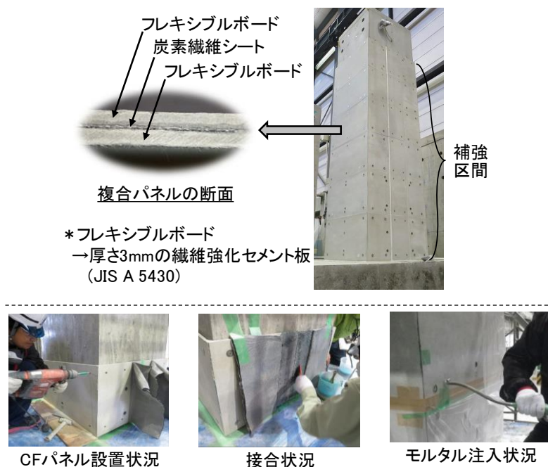
図-5.2.3 CF パネル工法の概要
