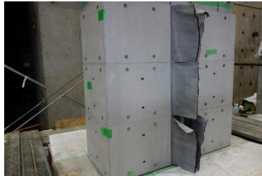
(5) CF パネル設置完了
