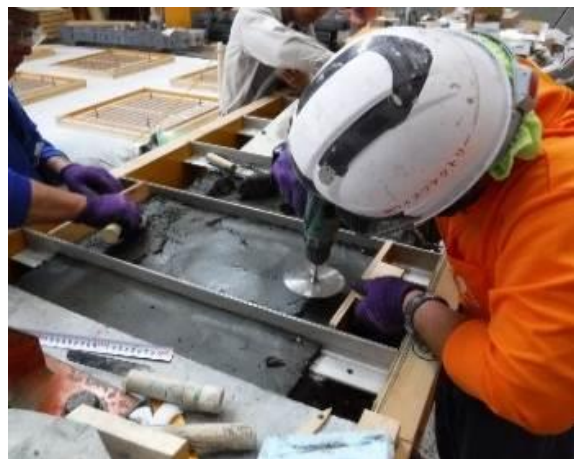
写真-4.4.4 超高強度繊維補強モルタルの締固め状況
