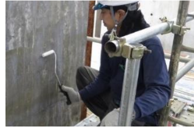
(3) プライマー塗布
