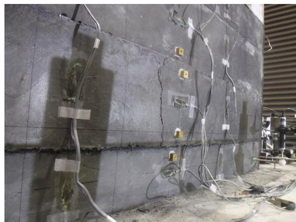
写真-4.4.68 +9δ, (限界状態 2) 圧縮側 基部から 2 段目の補強部に縦方向のひび割れ
