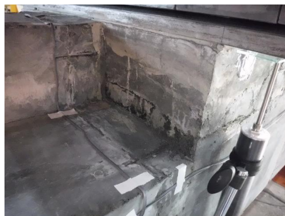
写真-4.4.14 載荷版付近の状況
