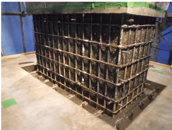
写真-4.4.32 目荒らし後の補強区間の状況
