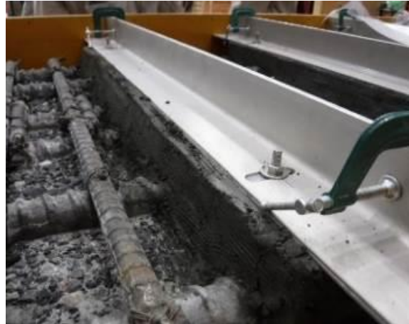
写真-4.4.2 ひび割れ誘発目地の設置状況
