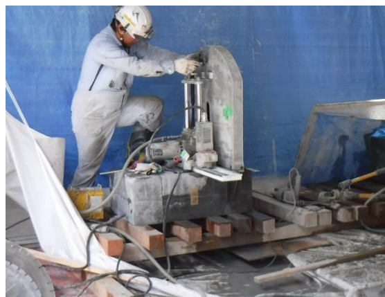
写真-4.4.8 ウォールソーによる切断状況
