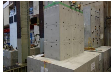
(12) CF パネル施工完了
