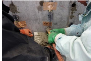
(11) かぶり部のモルタル注入
