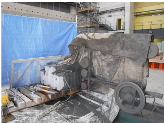
写真-4.4.7 ワイヤソーによる切断状況
