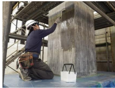
② プライマー塗布
