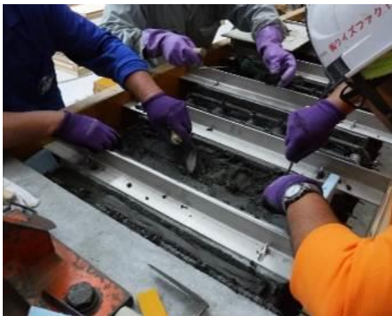
写真-4.4.3 超高強度繊維補強モルタルの塗付け状況
