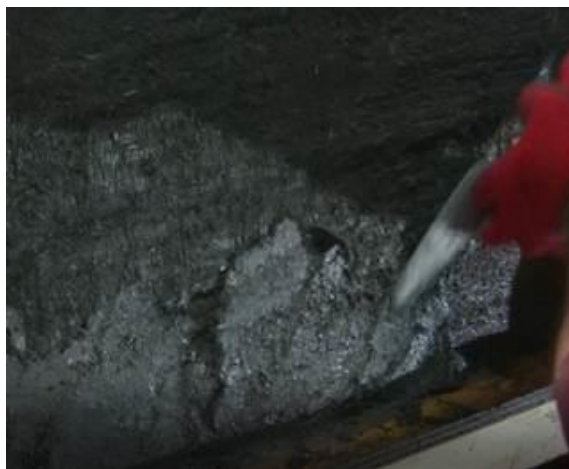
写真-4.3.3 薄層の塗付け
