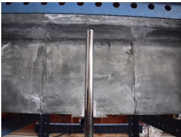
写真-4.4.30 等曲げ区間 下端側目地の状況
