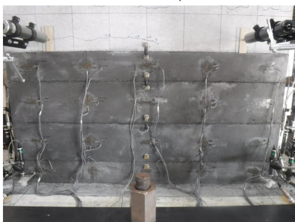
写真-4.4.79 +5 \delta (限界状態 2) 圧縮側 基部から 3 段目の補強部に縦方向のひび割れ
