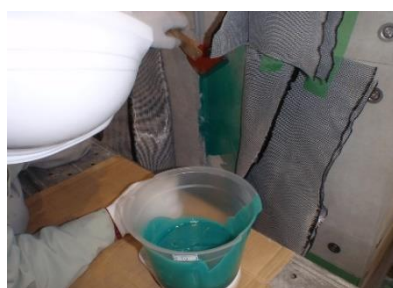
② ボード面への樹脂塗布
