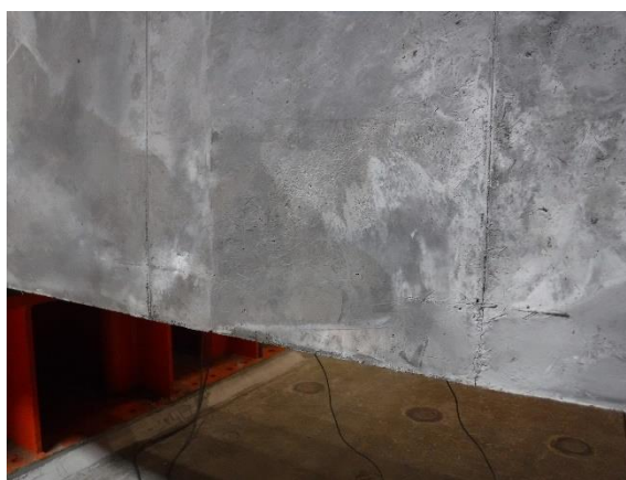
写真-4.4.17 等曲げ区間下面側の目地周辺状況 (目地以外に曲げひび割れは未確認)
