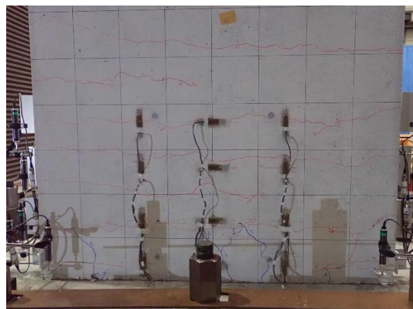
写真-4.4.56 -7\delta (限界状態 2) 圧縮側 基部に縦方向のひび割れ発生
