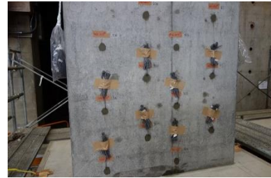
(12) PHb 施工完了
