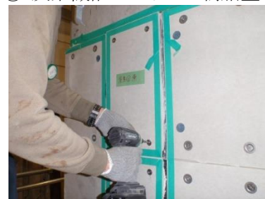
⑥ 接合パネルのアンカー設置
