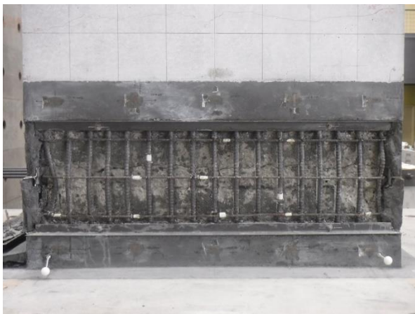
写真-4.4.85 実験終了後 正載荷圧縮側
