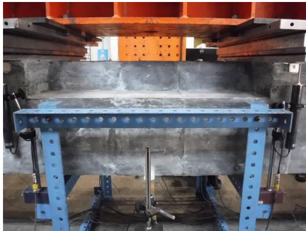
写真-4.4.6 等曲げ区間におけるひび割れ状況 (STEP4)
