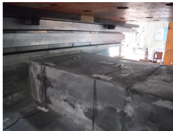
写真-4.4.16 載荷版付近の状況
